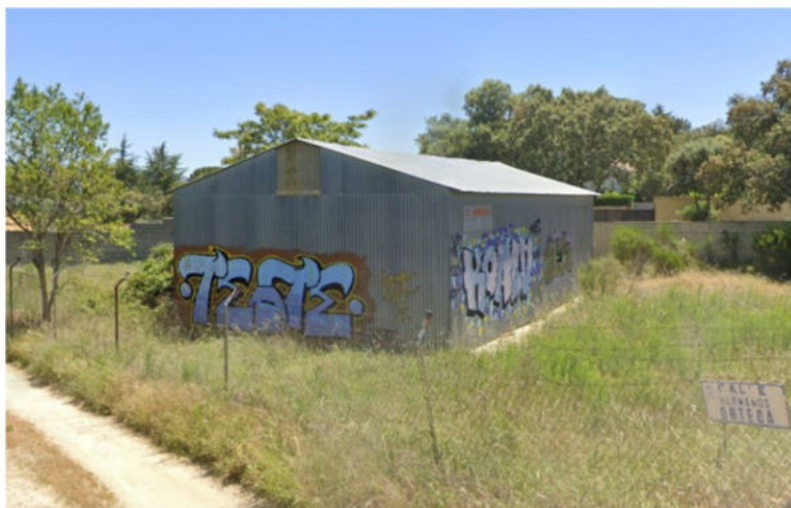
Figura 2. Nave existente en el ámbito de estudio.
