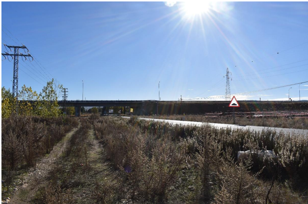
Cruce de la R2 sobre la M-116.
