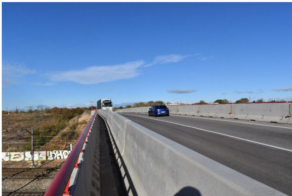
Puente sobre las líneas ferroviarias.
