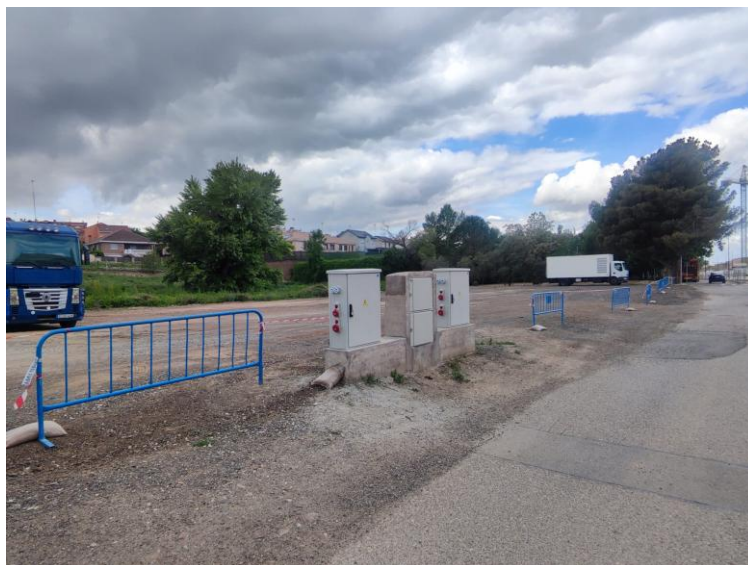
Punto de aforo en la Calle Mercado.
