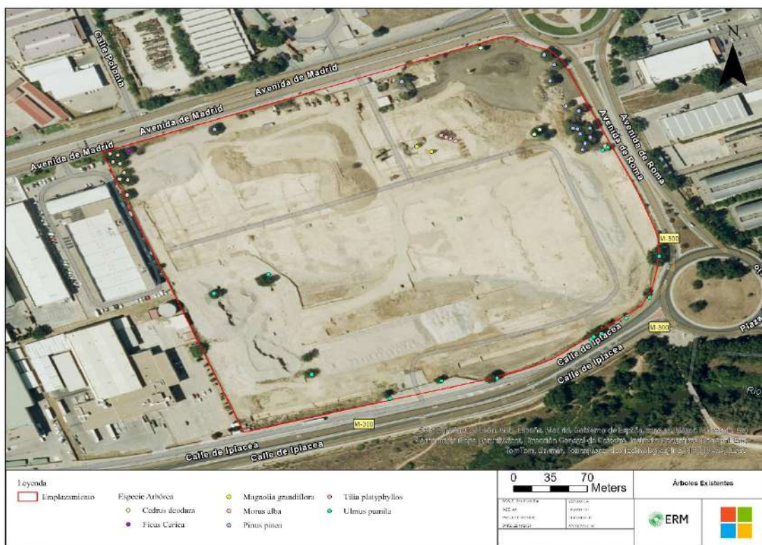
Figura 11. Arbolado presente en el emplazamiento (2024)
