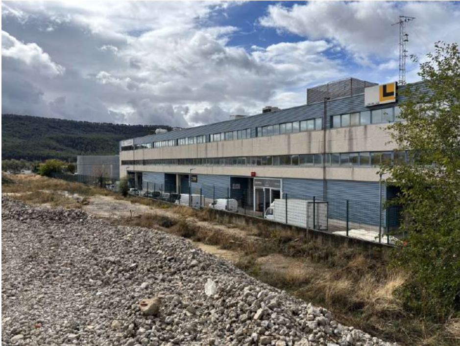
imagen de la valla perimetral hacia propiedades colindantes en el lado oeste
