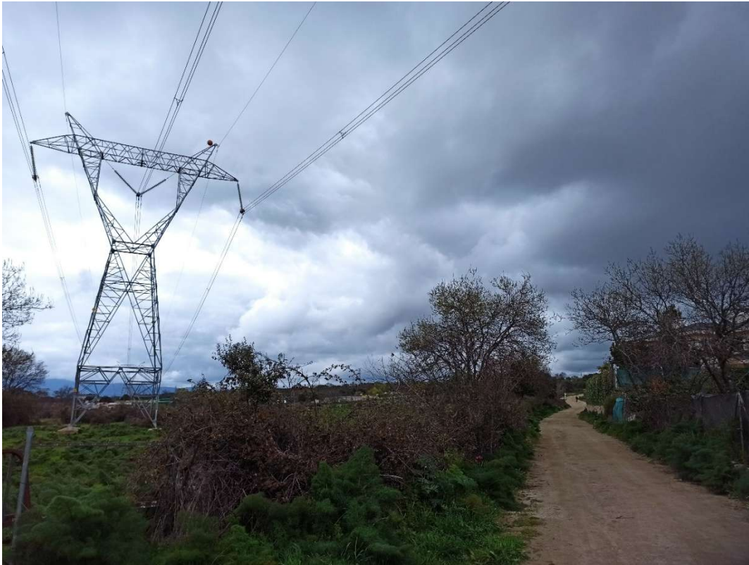
La Colada de Cercado del Charco de la Hoya.
