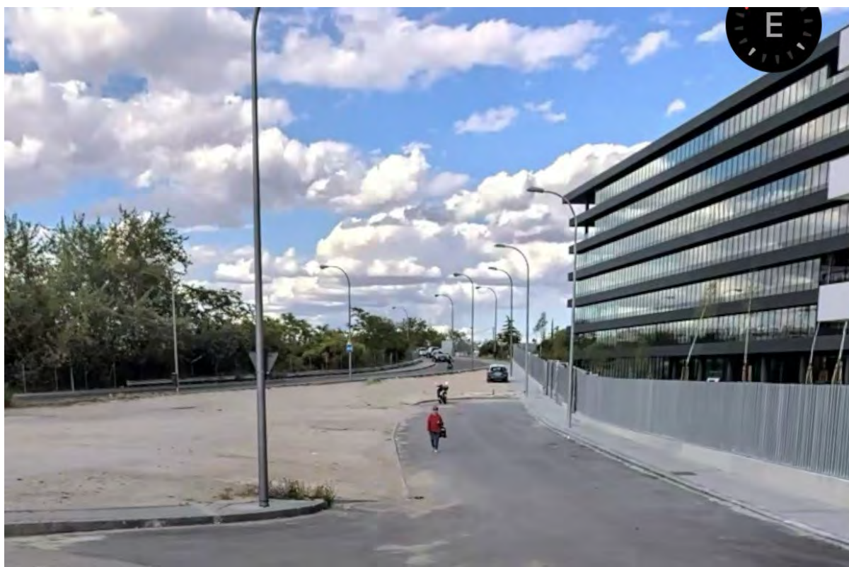
Figura 14: Limite del APR 16.02 con Suelo urbano del Complejo de oficinas Helios
