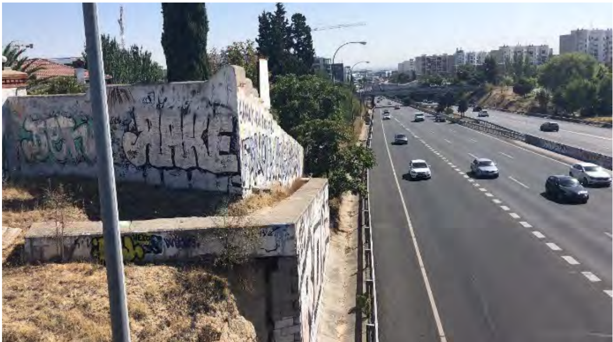
FOTO n°5. Visión lateral del Muro que produce un estrangulamiento en la M40 por la antigua ejecución del carril de salida a la M-11 en el P.K. 3+000.
