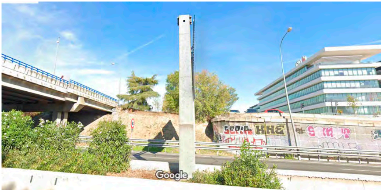
FOTO n°7. Visión del muro existente para salvar la diferencia de cota entre el tronco de la M-40 y la calle Vía de los Poblados en su acceso a la calle de Gregorio Sánchez Herráez.
