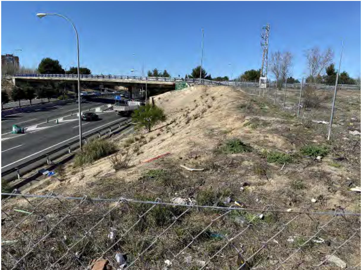
FOTO n°6. Visión del desmonte que ha producido la antigua ejecución del carril de salida a la M-11 en el P.K. 3+000 de la M-40, y que ha invadido la delimitación del APR 16.02, delimitado por una valla de malla metálica.
