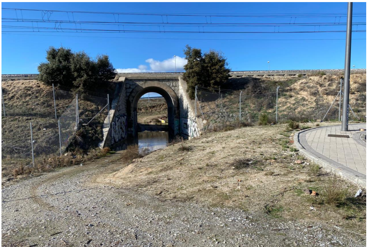
Pontón de paso bajo la Línea de FFCC, para el acceso a las infraestructuras hidráulicas y al otro lado del Línea Ferroviaria. Su acceso actual es desde el fondo de saco en el que acaba la calle Gregorio Marañón y a través de la manzana privada TPT-2
