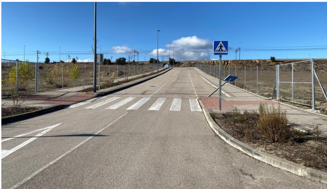
Tramo de la calle Gregorio Marañón que separa la parcela TPT-1 a la derecha de la TPT-2 a la izquierda. Al fondo se ve el pontón de acceso bajo la Línea de FFCC, que da acceso a las infraestructuras hidráulicas que discurren al otro lado del Línea Ferroviaria
