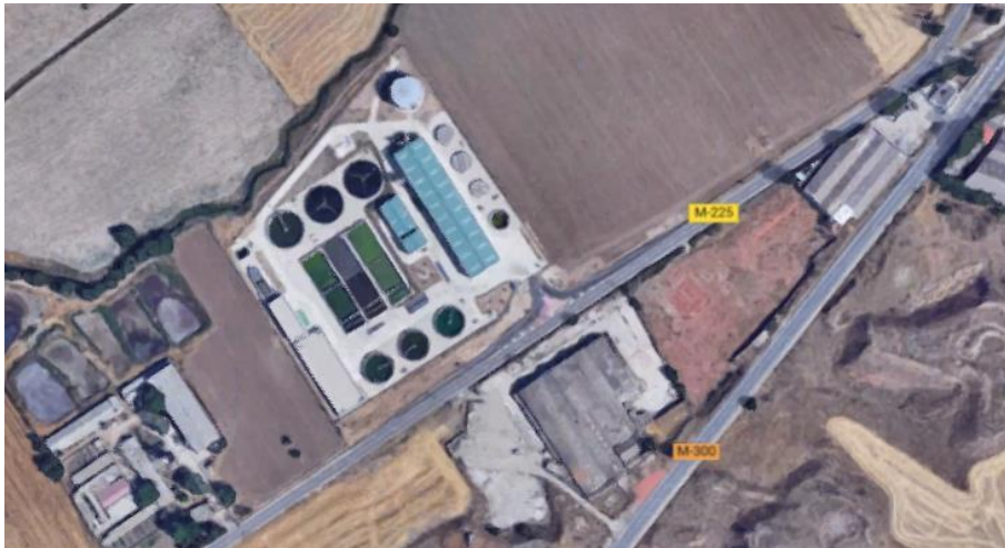
Vista Aérea de la EDAR de Torres de la Alameda
