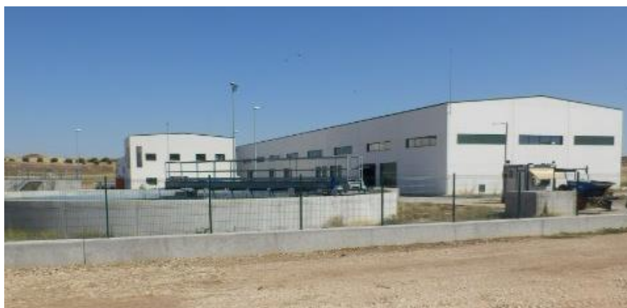
Vista exterior de la EDAR de Torres de la Alameda
