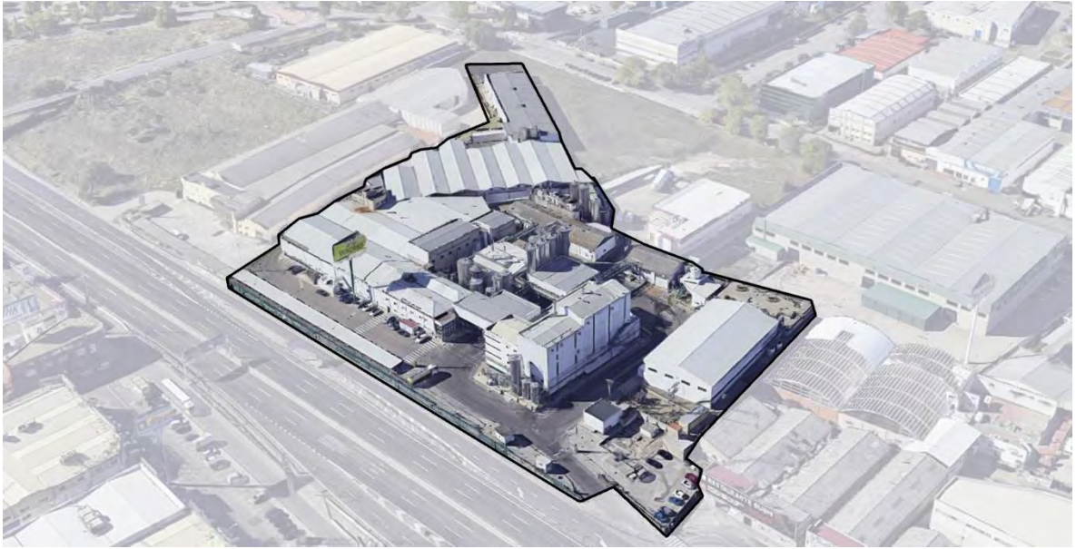
Figura 211: Quesería Entrepinares, ejemplo de gran complejo industrial de 1977.
