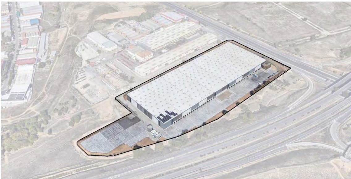
Figura 210: Ejemplo de nave industrial moderna de uso logístico y grandes dimensiones en el polígono Calfersa.
