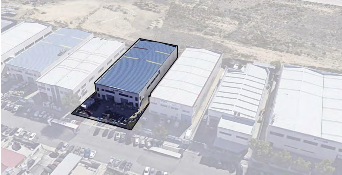
Figura 209: Ejemplo de nave industrial moderna de dos plantas y tamaño moderado.
