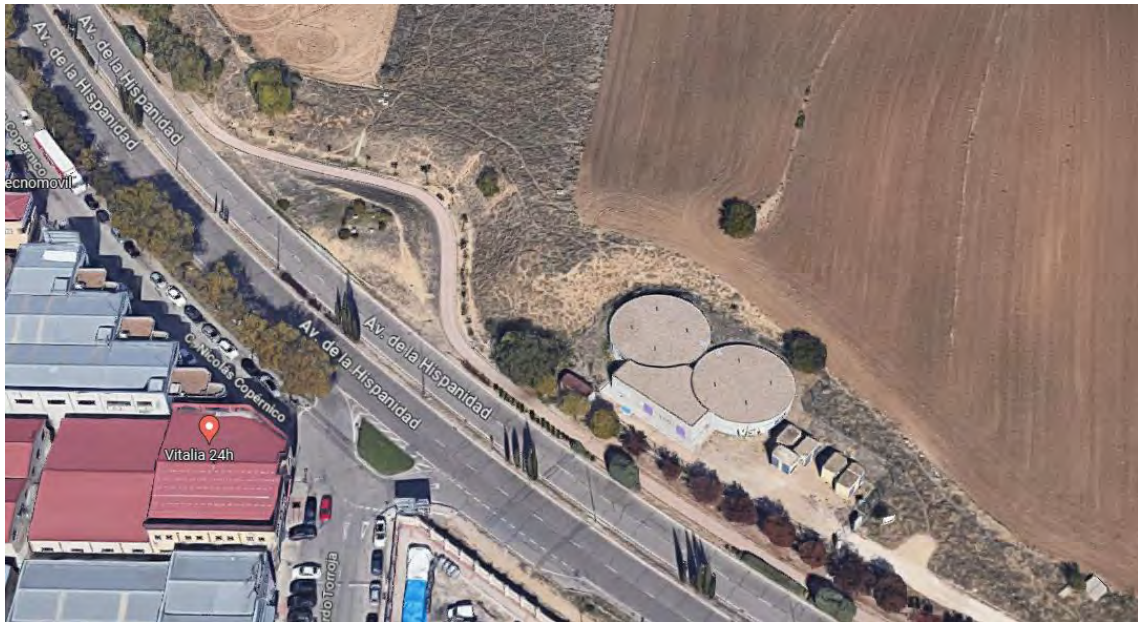
Figura 306: Depósito y grupo de presión Avenida de la Hispanidad
