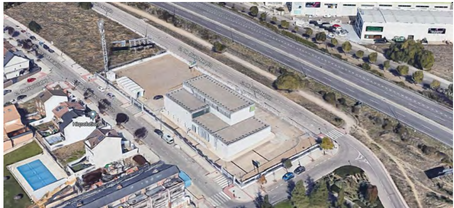
ETD FREGACEROS (ESTACIÓN COMPACTA)
