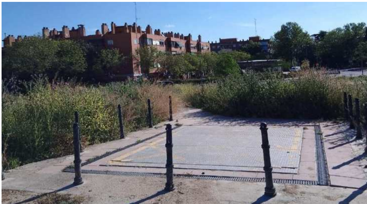
Figura 88. Vistas del ámbito (instalaciones del Metro de Madrid). Elaboración propia
