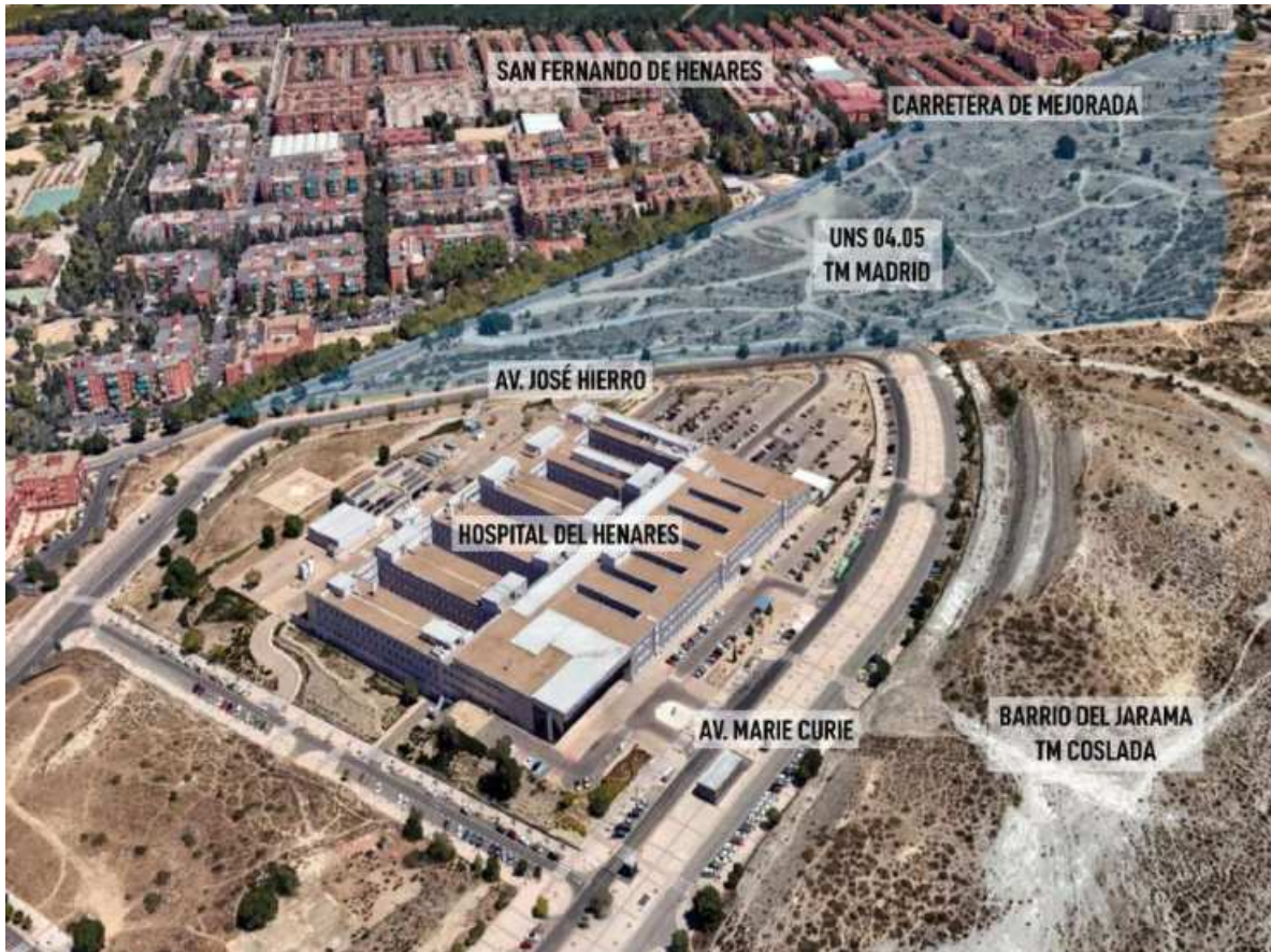
Figura 106. Vista aérea del Hospital del Henares. Fuente: Google Earth y elaboración propia
