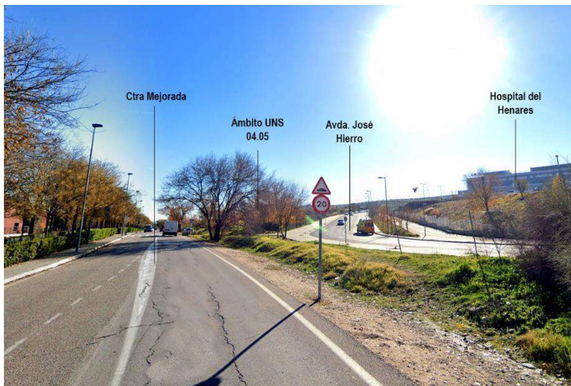
Figura 122. Tramo norte de la calle "Carretera de Mejorada"
