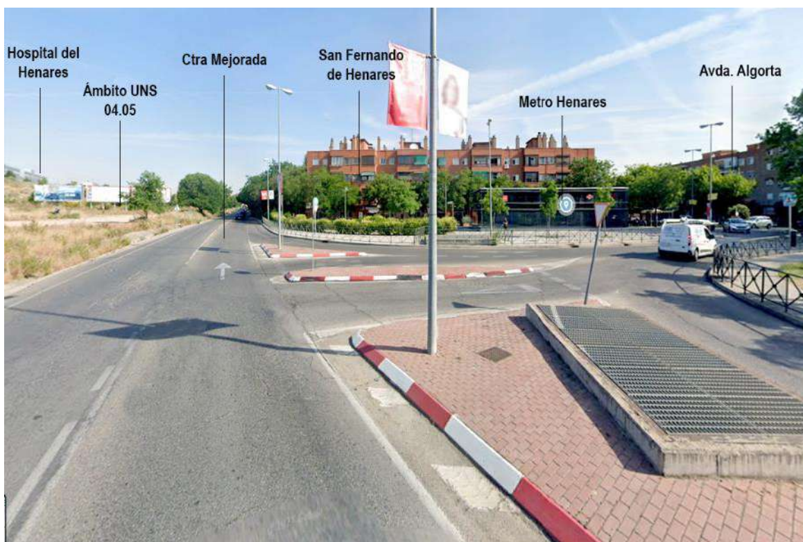
Figura 123. Tramo central de la calle "Carretera de Mejorada"
