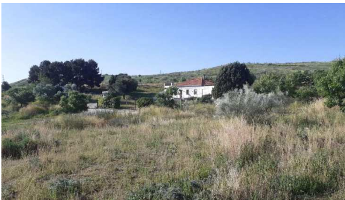
Figura 89. Vistas del ámbito. Construcciones existentes. Elaboración propia
