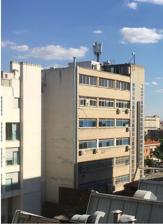
Fotografía fachada a patio trasero
