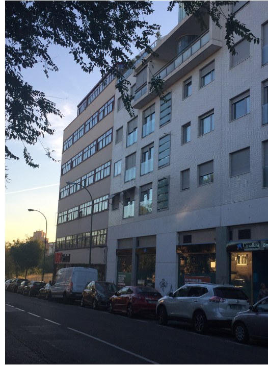
Medianera con edificio de viviendas.
