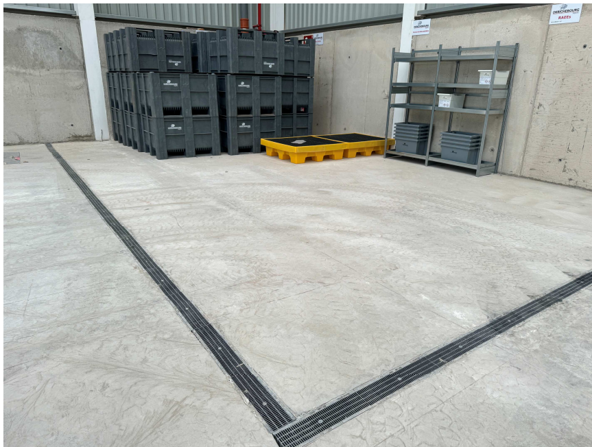
Ilustración 7. Zona residuos peligrosos almacén Málaga
