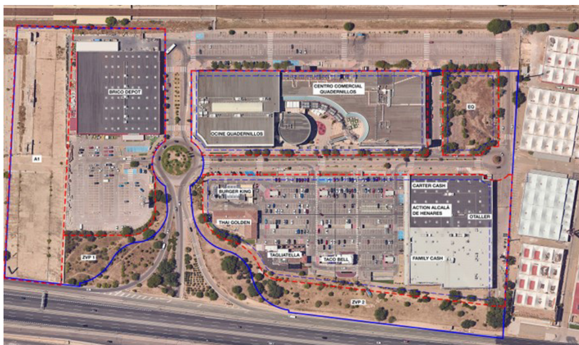
Estado actual del Sector 33-D "Cuadernillos".
