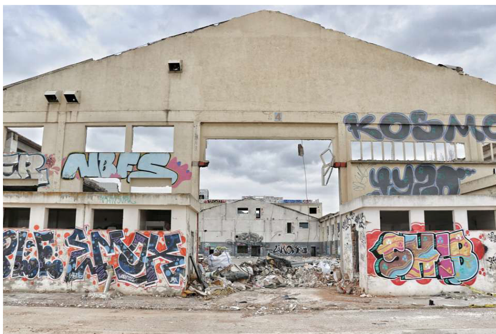
Imágenes del estado de la edificación. La desaparición de las instalaciones de Industria Montenegro ha generado un espacio industrial vacante en una localización estratégica de la ciudad.
