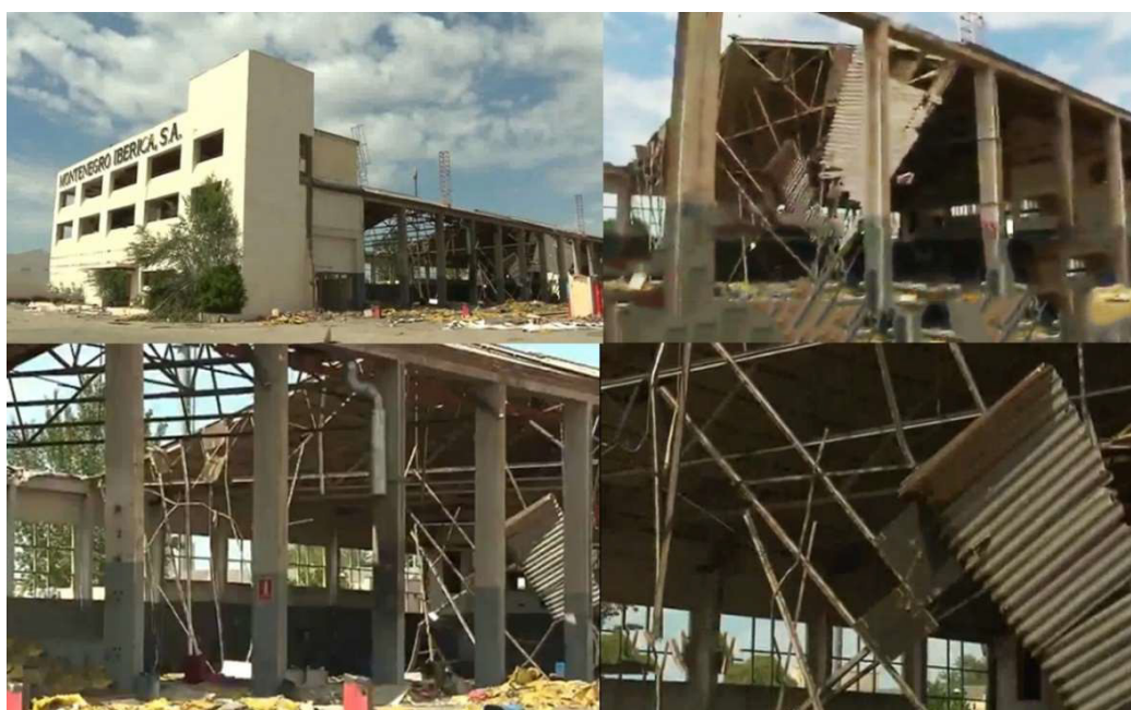
Imágenes del estado de la edificación. La desaparición de las instalaciones de Industria Montenegro ha generado un espacio industrial vacante en una localización estratégica de la ciudad.
