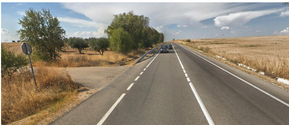
Figura 3. Acceso al "Camino del Rey" desde la carretera M-224, que da acceso a la zona oeste
