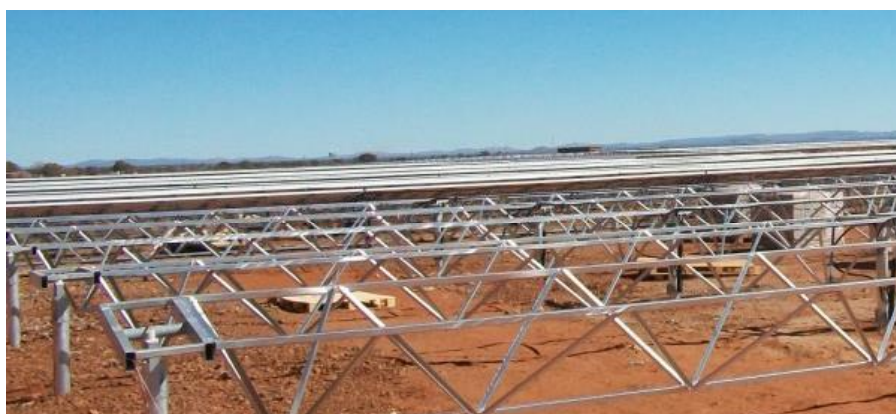
Imagen 3. Montaje de estructura solar con perfiles hincados directamente en el terreno
