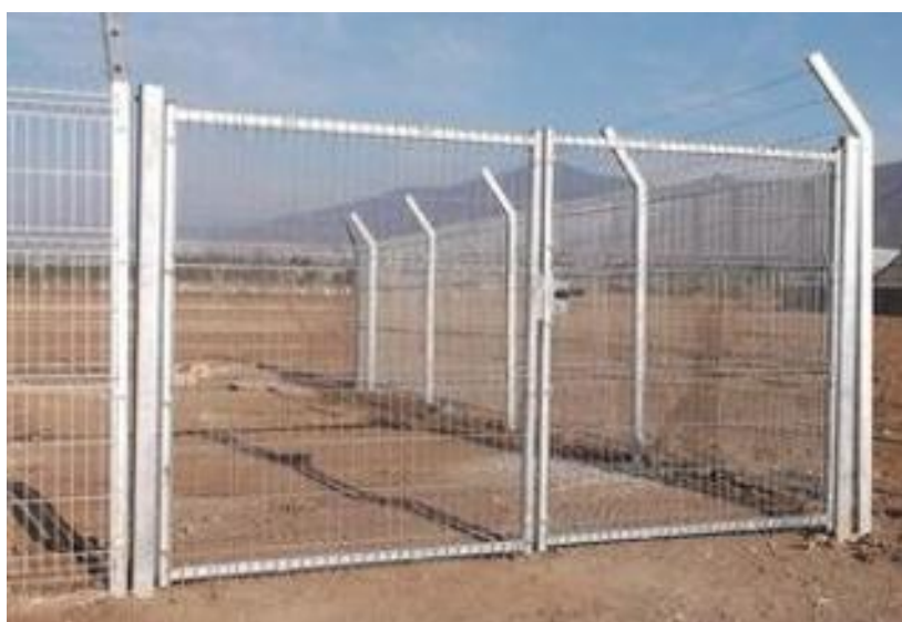
Imagen 1. Detalle de portón de dos hojas batientes tipo Acmafor
