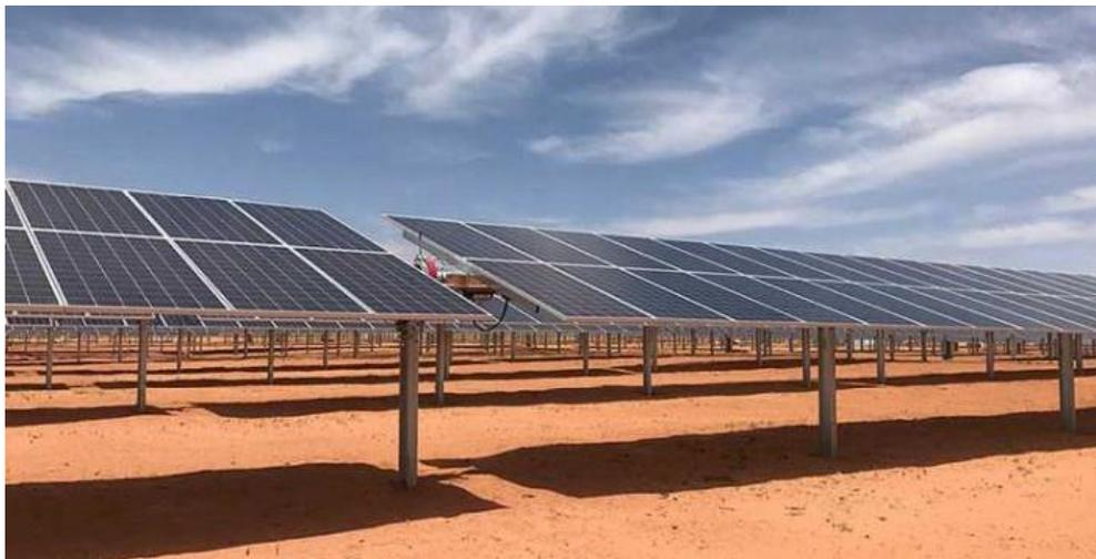
**Imagen 8.** Seguidor monofila tipo 2V
