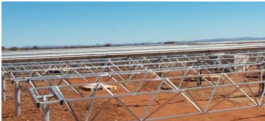
Imagen 3. Montaje de estructura solar con perfiles hincados directamente en el terreno
