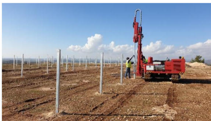
Figura 4. Perfil de acero hincado (izquierda). Máquina hincadora y operario (derecha).
