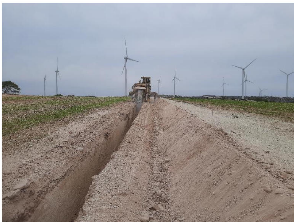
Ilustración 16: Excavación de zanjas.
