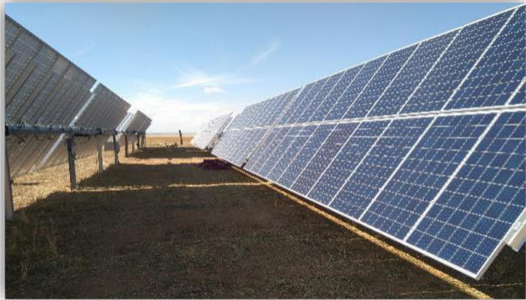
Figura 2. Ejemplo de seguidor de un eje Norte-Sur.
