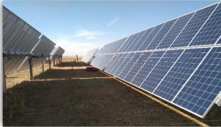
Figura 2. Ejemplo de seguidor de un eje Norte-Sur.
