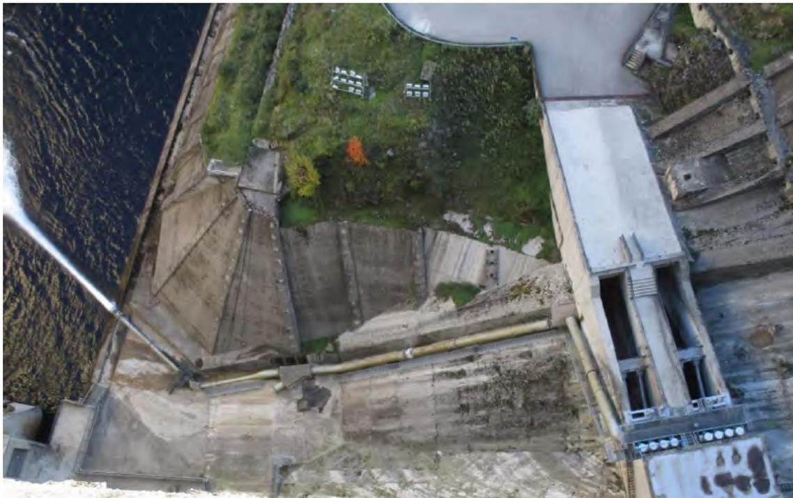
En la ejecución de la conducción de derivación de los desagües de medio fondo encargadas en la actualidad de verter el caudal ecológico se dejó construida una derivación, con un tapón, de modo que la conducción forzada de la futura minicentral dispusiera de ésta como punto de conexión.
