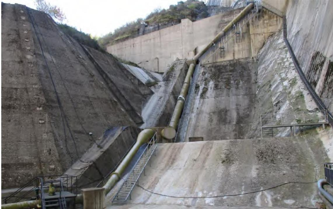
Con el fin de aprovechar energéticamente el vertido de los caudales, Canal de Isabel II plantea desde un primer momento la posibilidad de instalar una nueva Minicentral Hidroeléctrica, ubicada a pie de presa y destinada a turbinar el caudal conducido por este nuevo desagüe que será precisamente la base de partida para la implantación y diseño de la minicentral y sus instalaciones.
