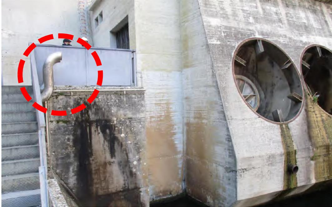
En el caso del cable de señal del caudalímetro este será repuesto por el exterior del edificio, mientras el transmisor del caudalímetro será trasladado al interior de la minicentral.
