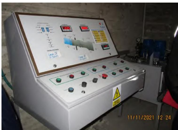
Desde este punto parten el conducto con el cableado para el posicionamiento de la válvula de regulación y la señal del caudalímetro, y los conductos del sistema oleohidráulico de la válvula. Todos estos se verán afectados por la implantación de la minicentral. Además, en el exterior de la presa y coincidiendo con la implantación del edificio y el relleno, existen dos conducciones de acero inoxidable 150mm para el vertido del agua de drenaje interno de la presa.
