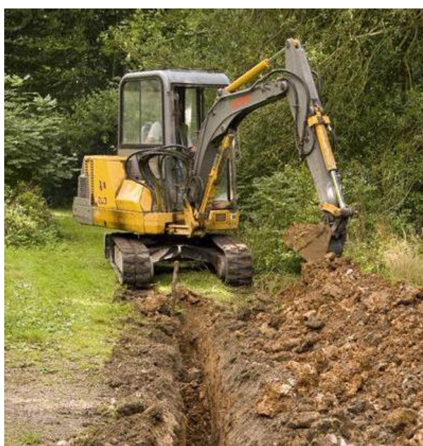
Imagen 17. Excavación de zanjas
