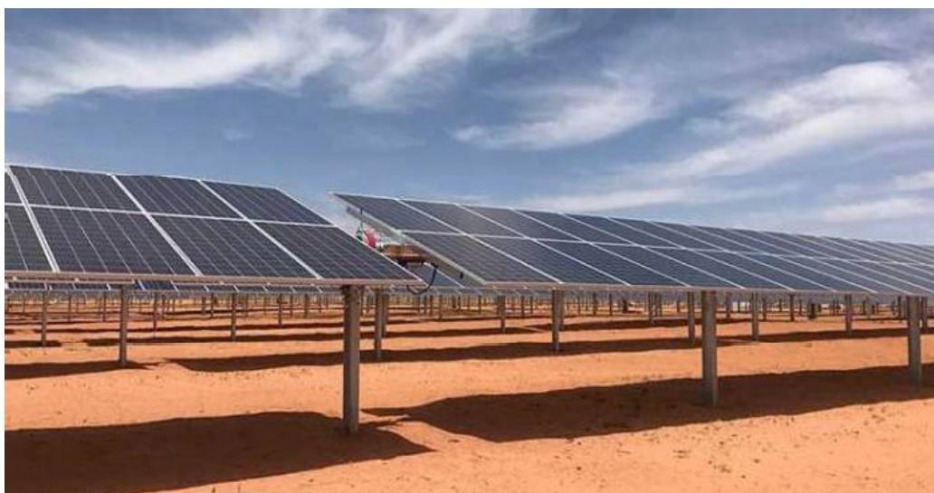
Imagen 6. Seguidor monofila tipo 2V
