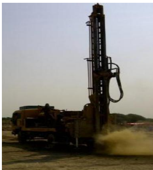
Imagen 16. Hincado de perfiles con maquinaria especializada
