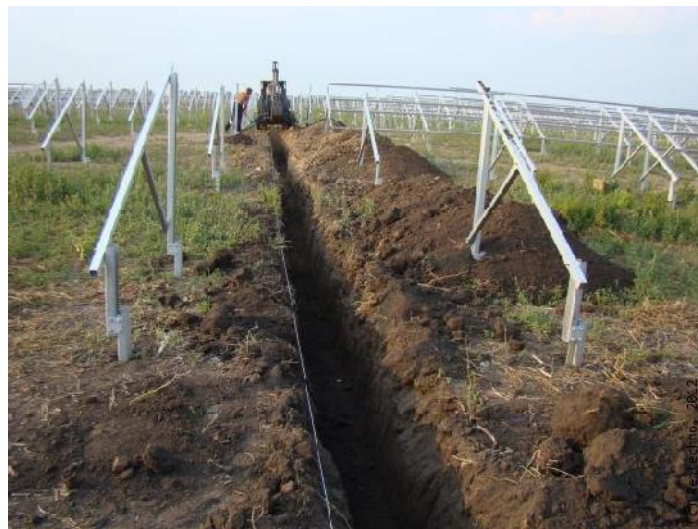
Imagen 19. Tendido de cable en zanja
