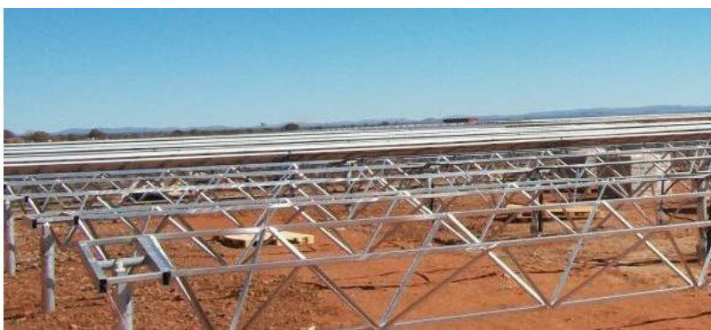
Imagen 18. Montaje de estructura solar con perfiles hincados directamente en el terreno
