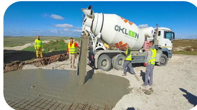
Producción en planta y puesta en obra en losa de muelle de carga
