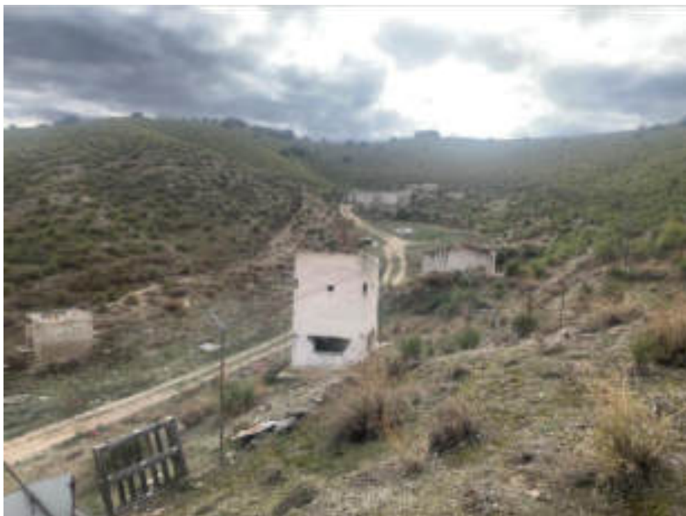
Figura 4.4.- Instalaciones abandonadas en la zona central del permiso
