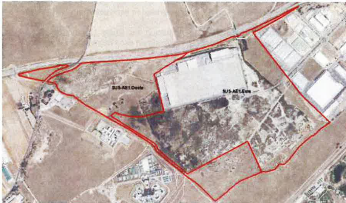
Fig. 6.- Estado actual SUS-AE1 Este y Oeste. Fuente: Ortofotografía 2020.
