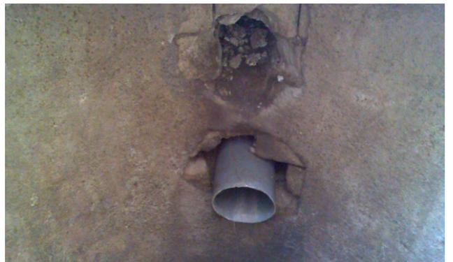
Conexión de tubería a pozo de registro sin perímetro sellado
