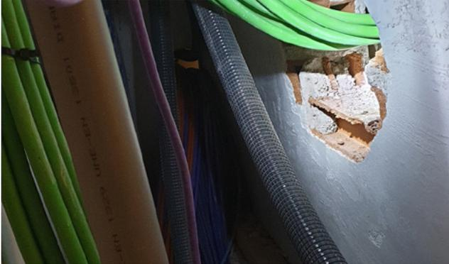
Interior de patinillo con deficiente conexión a armario exterior
