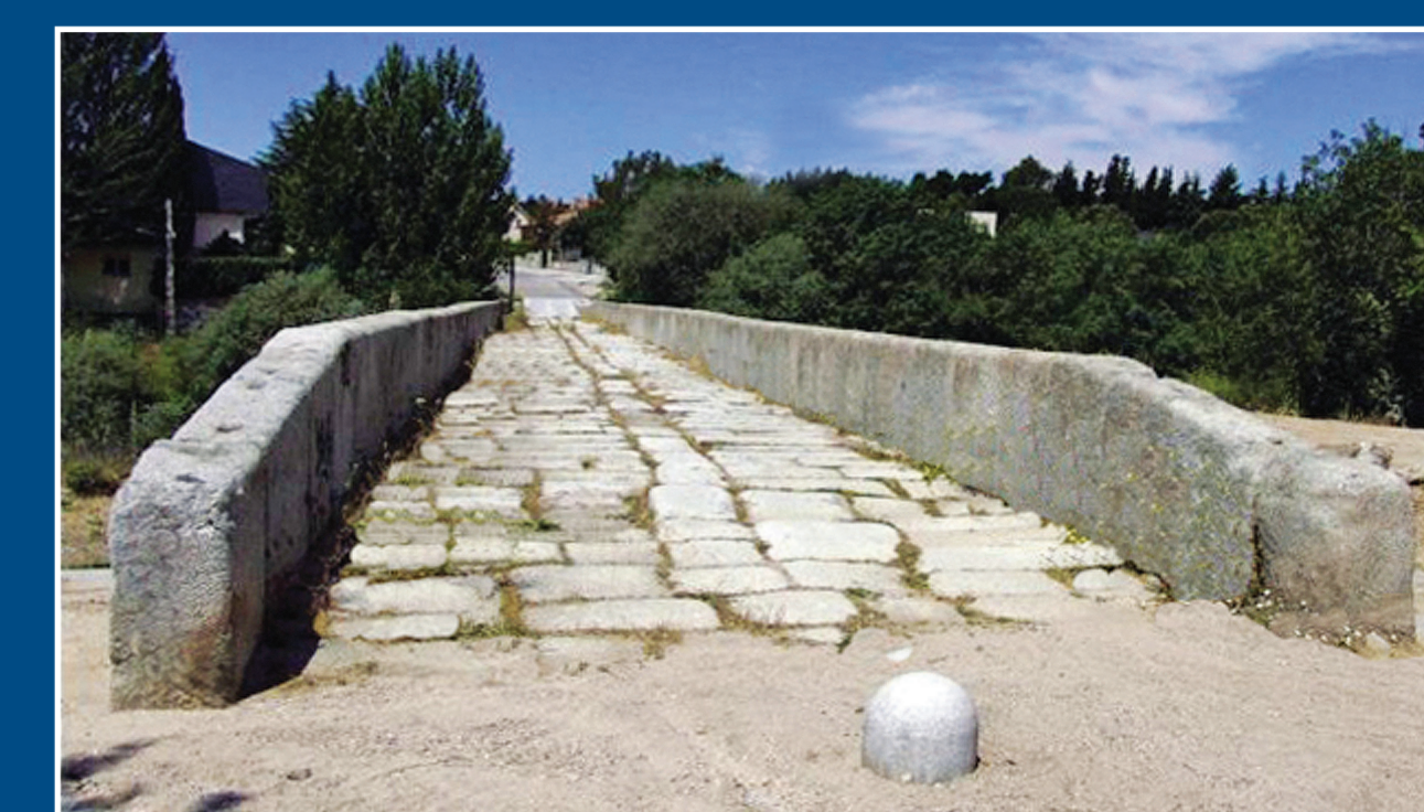
Enlosado del puente.
