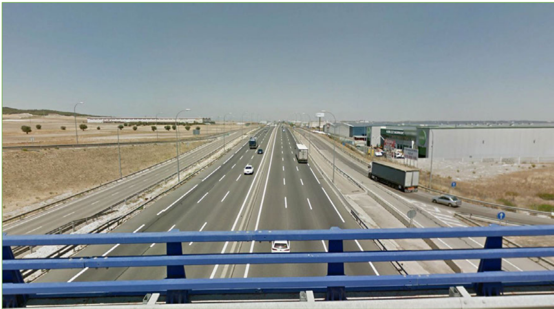
Figura 16. Tramo de la autovía A-4 en las proximidades del municipio de Valdemoro. Fuente: Google Earth.
