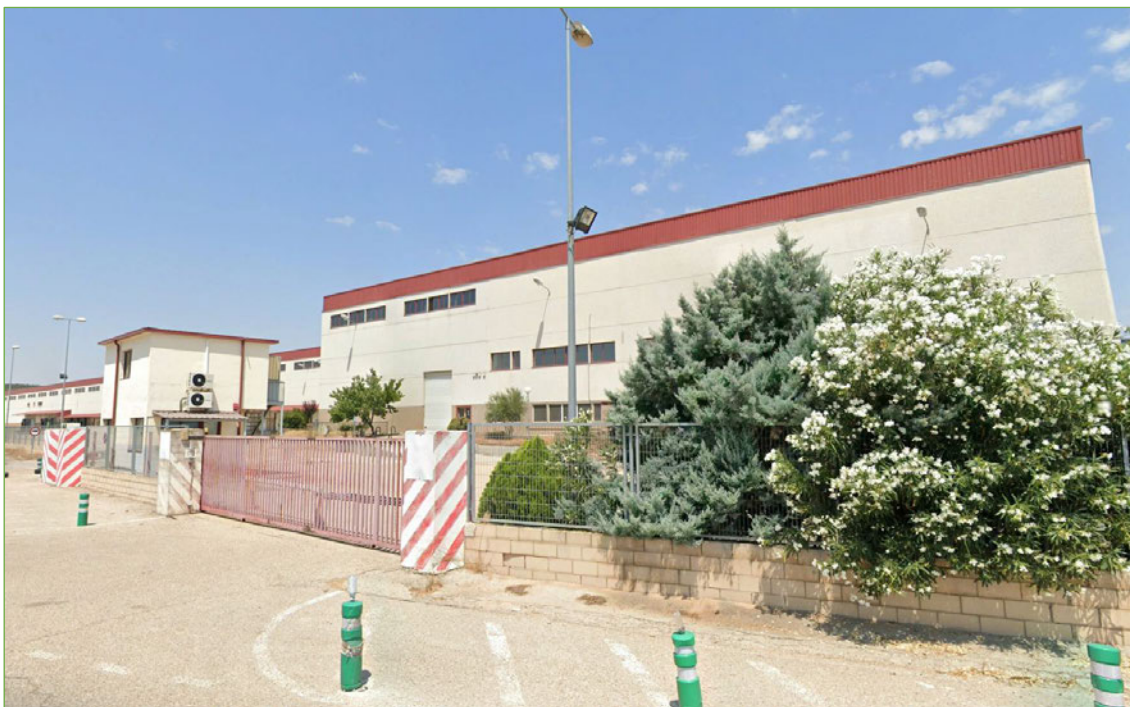
Figura 11. Servicio de logística "Transcentro Marín", localizado al sur de la planta fotovoltaica. Fuente: propia.
