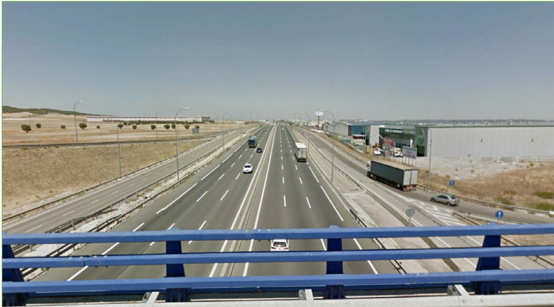
Figura 16. Tramo de la autovía A-4 en las proximidades del municipio de Valdemoro. Fuente: Google Earth.
