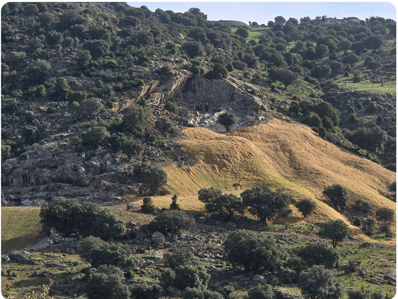
Foto 21. Restauración geomorfológica de cantera de granito y escombrera asociada en monte n.º 26 de UP “Cañal, Ladera y Entretérminos”. T. m. Alpedrete.
