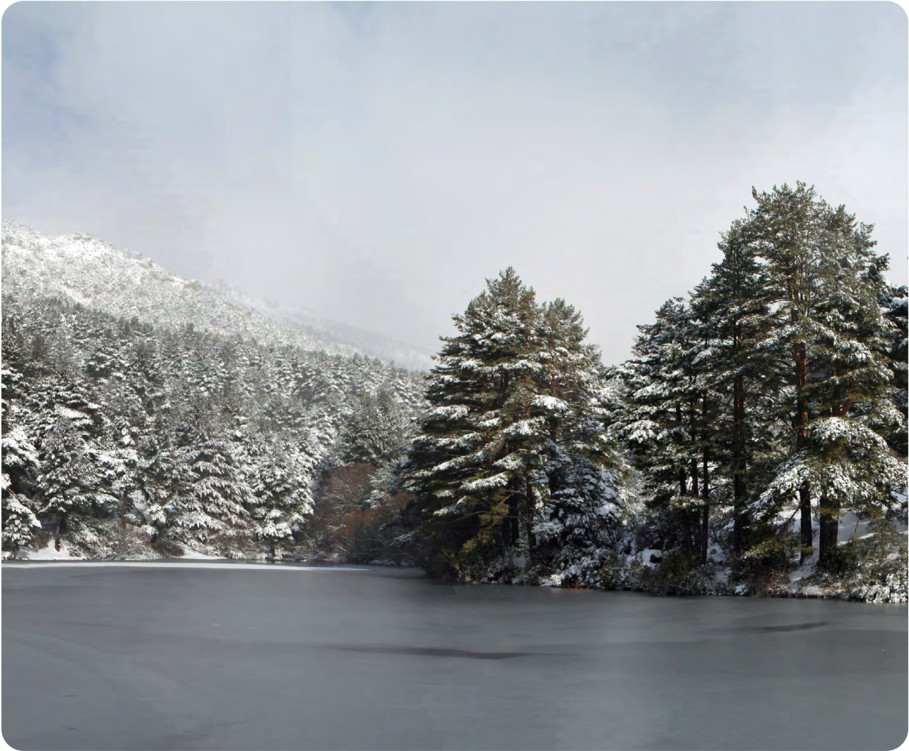
Foto 7. Presa de la Barranca. Monte n.º 24 de UP “Pinar de la Barranca” en el Parque Regional de la Cuenca Alta del Manzanares. T. m. de Navacerrada.
