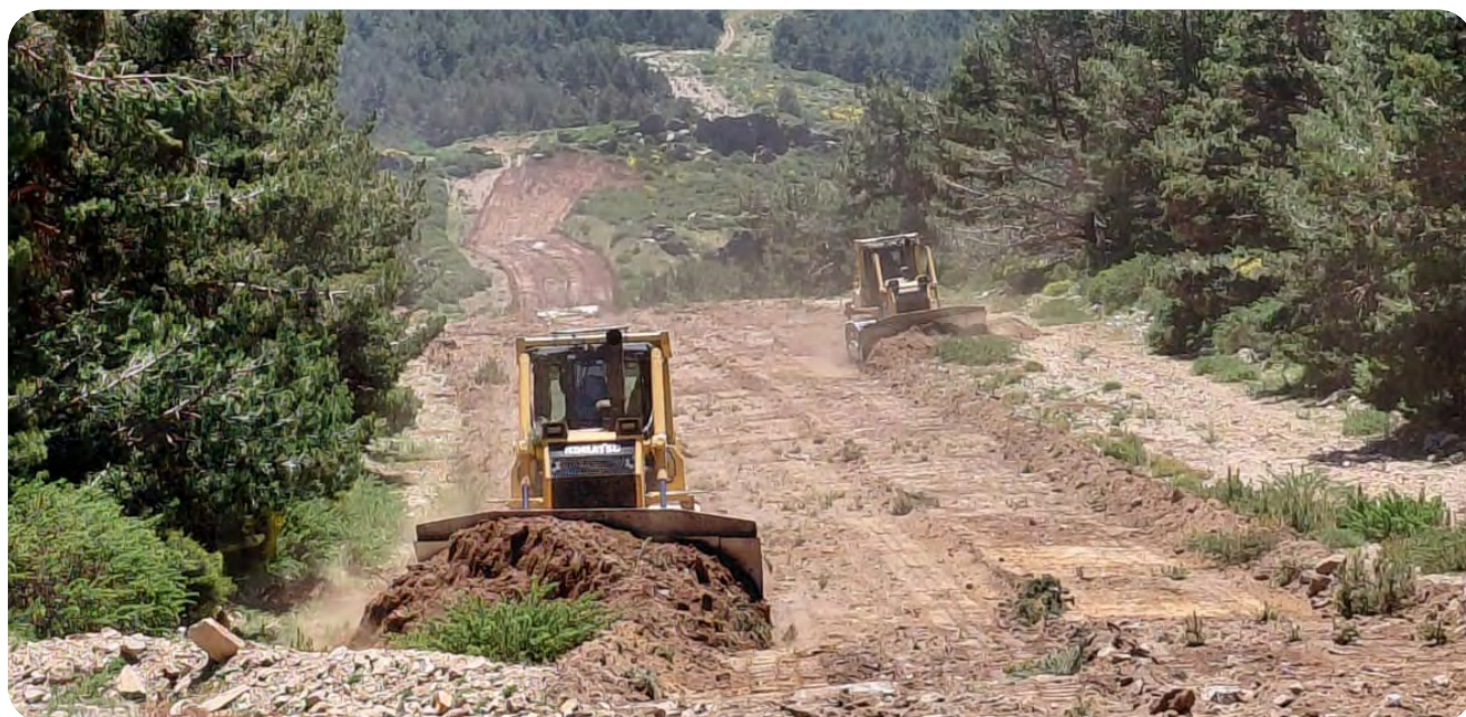
Foto 34. Bulldozers realizando repaso de cortafuegos. T. m. Montejo de la Sierra.
