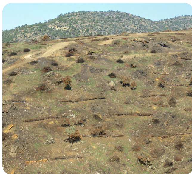
Foto 33. Fajinas y alarradas para control de la erosión de suelo tras incendio forestal. Monte n.º 54 de UP “Nahoncil y Agregados, Las Cabreras y Valle Lorenzo. T. m. San Martín de Valdeiglesias.
