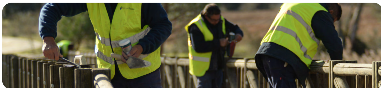
Foto 38. Pasarela de madera. Trabajos de conservación.
