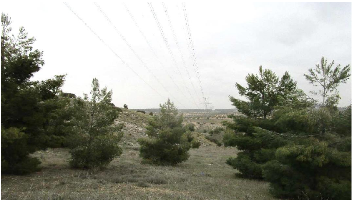
Vegetación de pinar atravesado por la línea eléctrica entre los apoyos 2 y 3.
