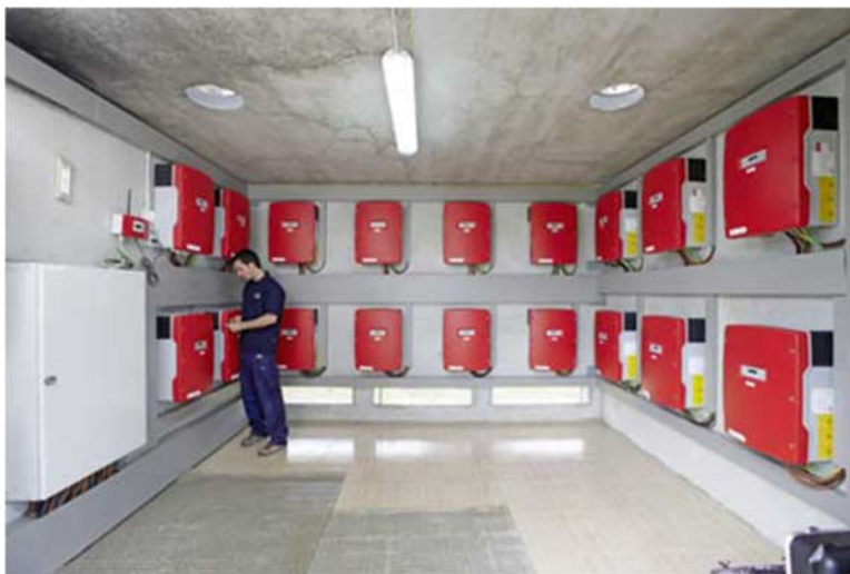
Imagen 6. Ejemplo de instalación de inversores distribuidos
