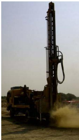
*Ilustración 15. Detalle de hincado de perfiles con maquinaria especializada*
