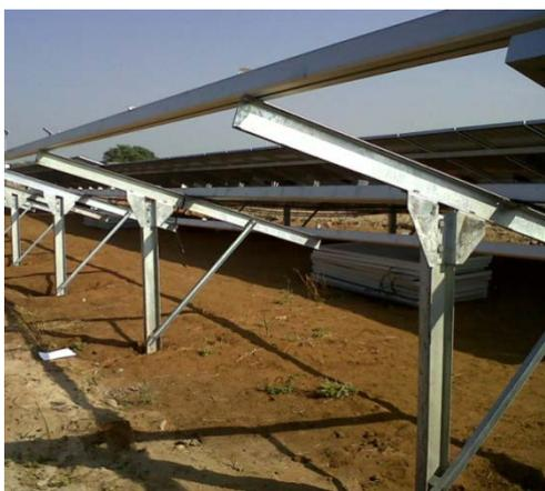
*Ilustración 13. Perfiles hincados directamente al terreno*
