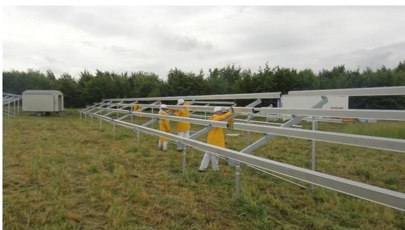
*Ilustración 16. Montaje de estructura fija con perfiles hincados directamente en el terreno.*
