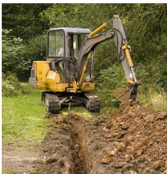
*Ilustración 12. Excavación de zanjas.*
