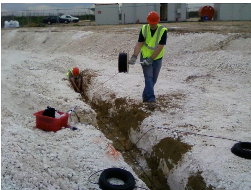
Ilustración 17. Tendido de cable en zanja.
