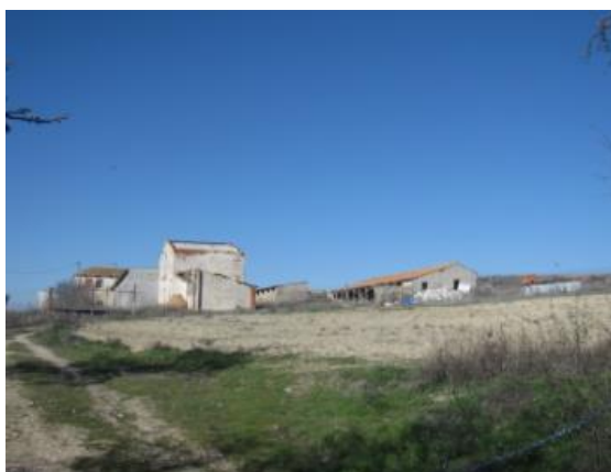
Fig. Edificación existente en la parcela 6 del polígono 36. Colmenar de Oreja
