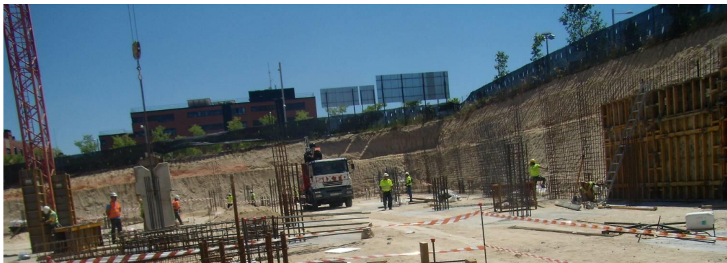
Figura: Advértase el entorno de cimentación bajo nivel de terreno natural, y proximidad de paredes de hormigón al lugar de trabajo del operario.
