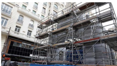
Obras de remodelación en el Metro de Gran Vía. (EFE)
