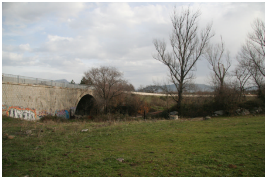
Punto 7. Puente de la N6 sobre el Guadarrama
