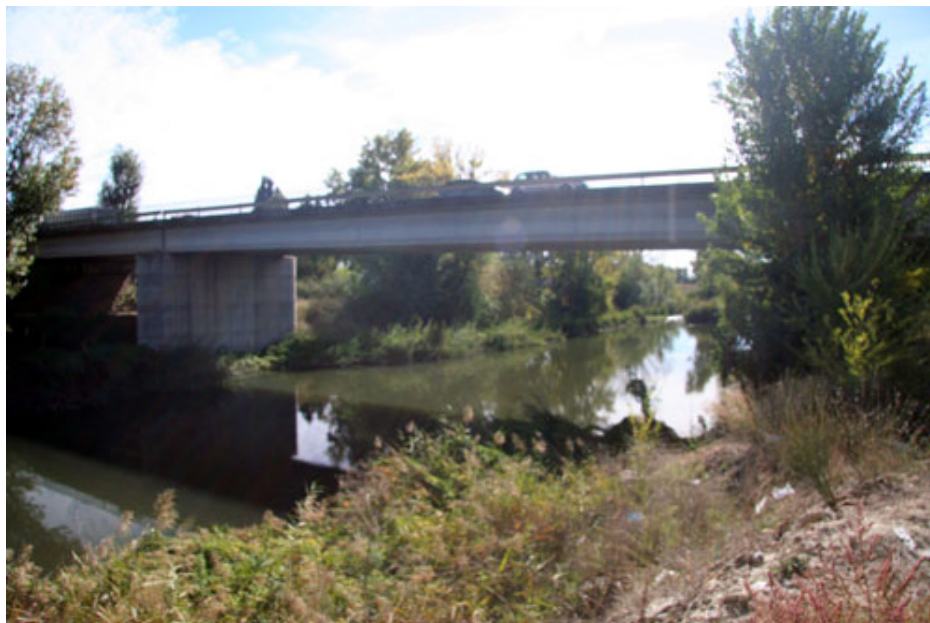
Punto 5. Puente de la M-203 sobre el Jarama
