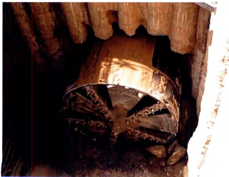
TBM breakthrough at Cuatro Vientos shaft.
