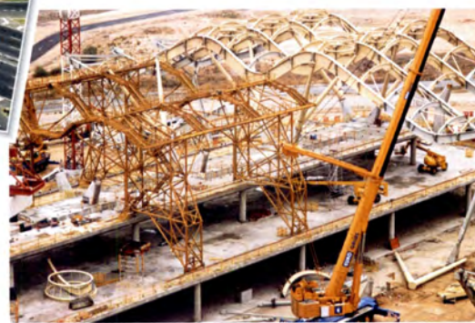
• Edificio Satélite. Nueva Terminal. Aeropuerto Madrid - Barajas.
