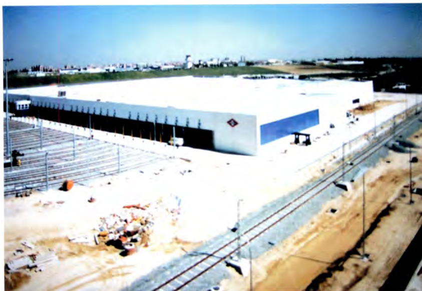
Cuatro Vientos depot and test track.
