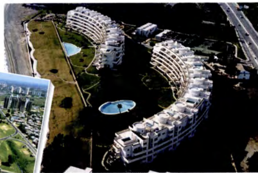
• Conjunto Residencial Los Granados Playa. Estepona. Málaga.
