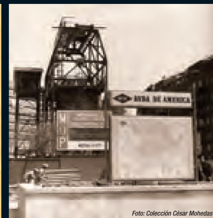
1973 - Nueva estación de Metro de Avenida de América (línea 4) y obras de línea 6
