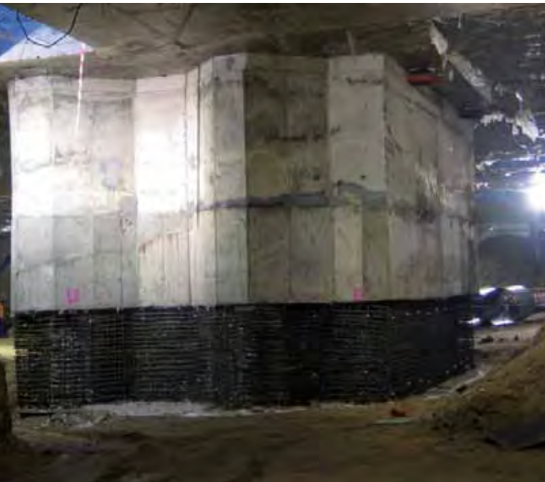
Refuerzo pilas de cimentación del Arco de Triunfo / Reinforcement of foundation piers for the Arco de la Victoria
