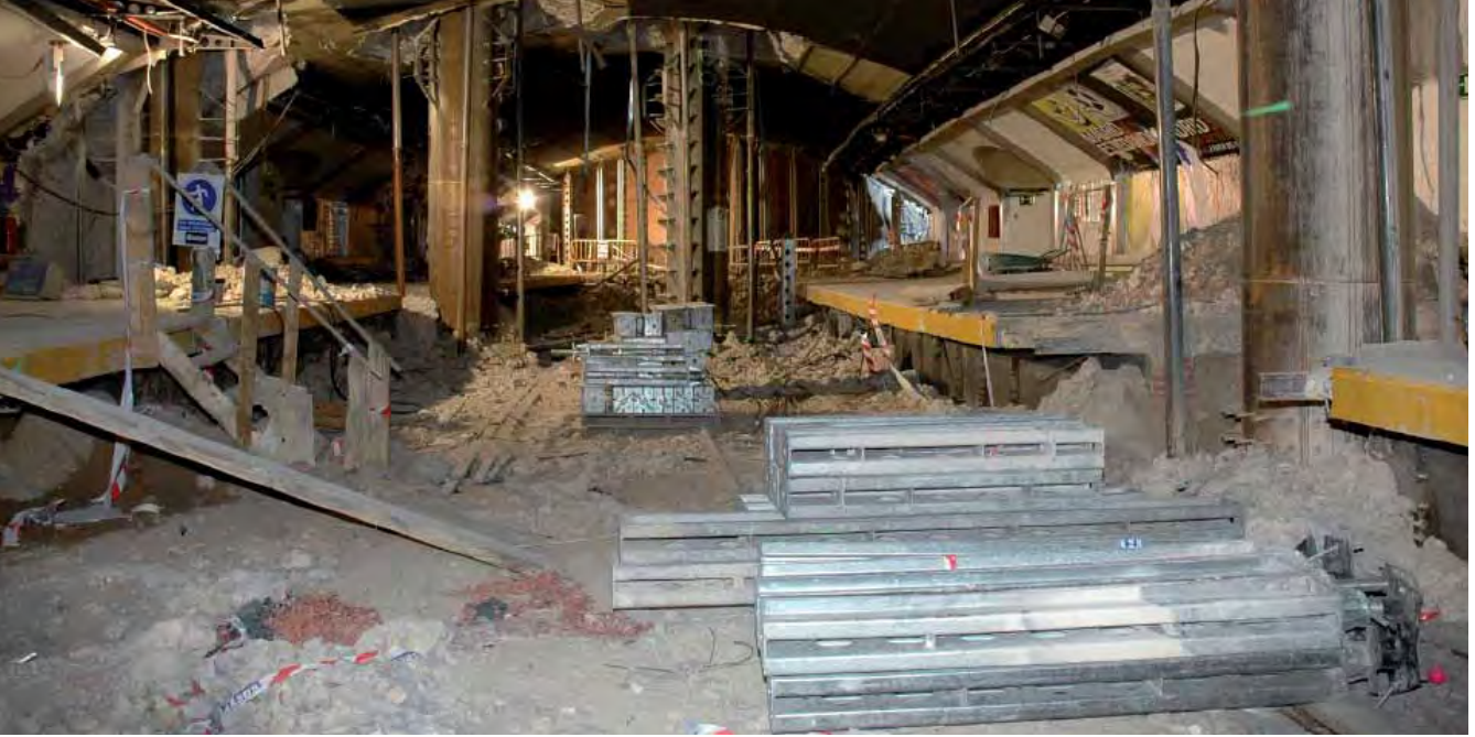
Obras en antigua estación línea 3. Septiembre 2006 / Work on the old Metro line 3 station. September 2006
