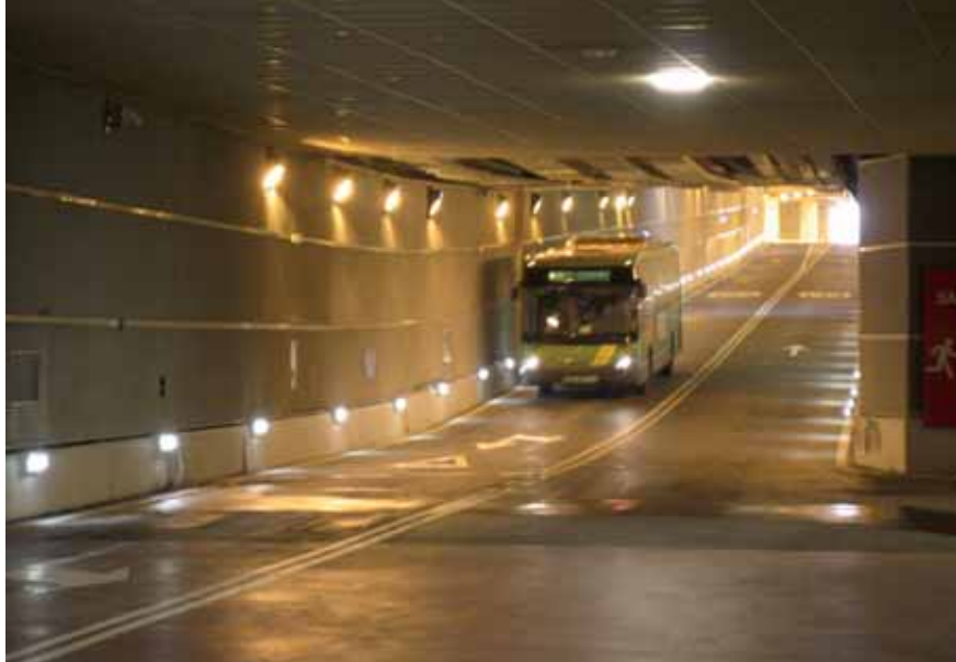
Túnel de acceso Access tunnel
