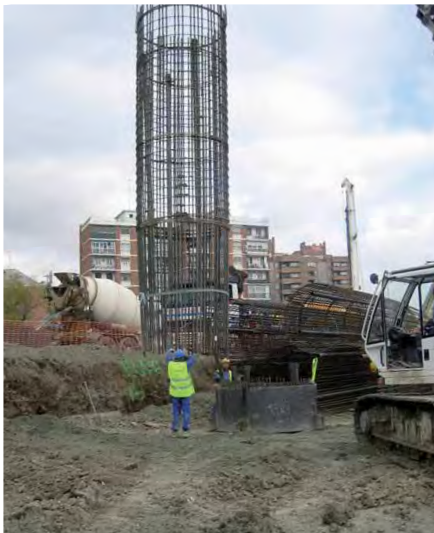
armadura de cimentación-pilote / reinforcement of pile foundations
