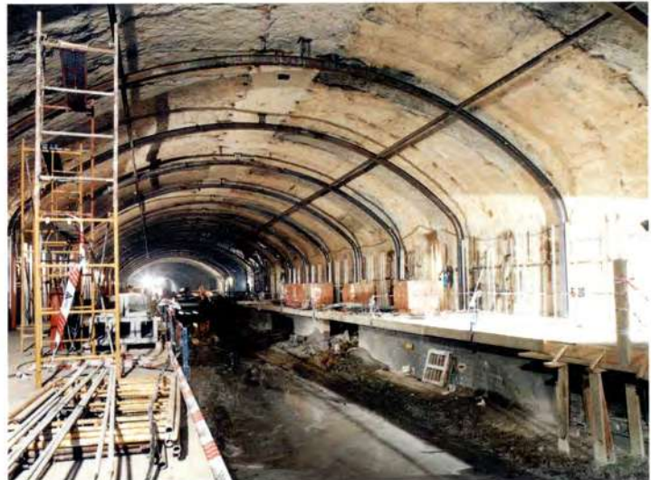
ANDENES Y CERCHAS ESTACION DE ARGUELLES.
