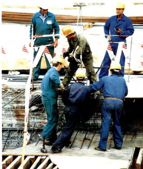
POSICIONAMIENTO DEL GATO DE PRETENSADO.
