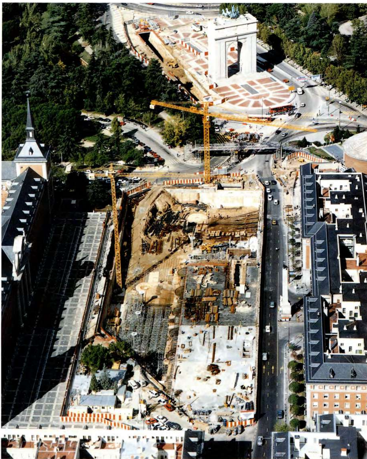
VISTA AEREA DE LAS OBRAS DEL INTERCAMBIADOR.
