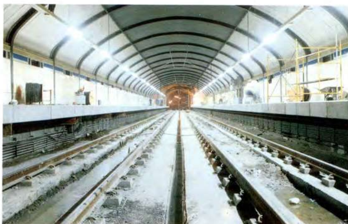
ACABADOS ESTACION DE ARGÜELLES.
