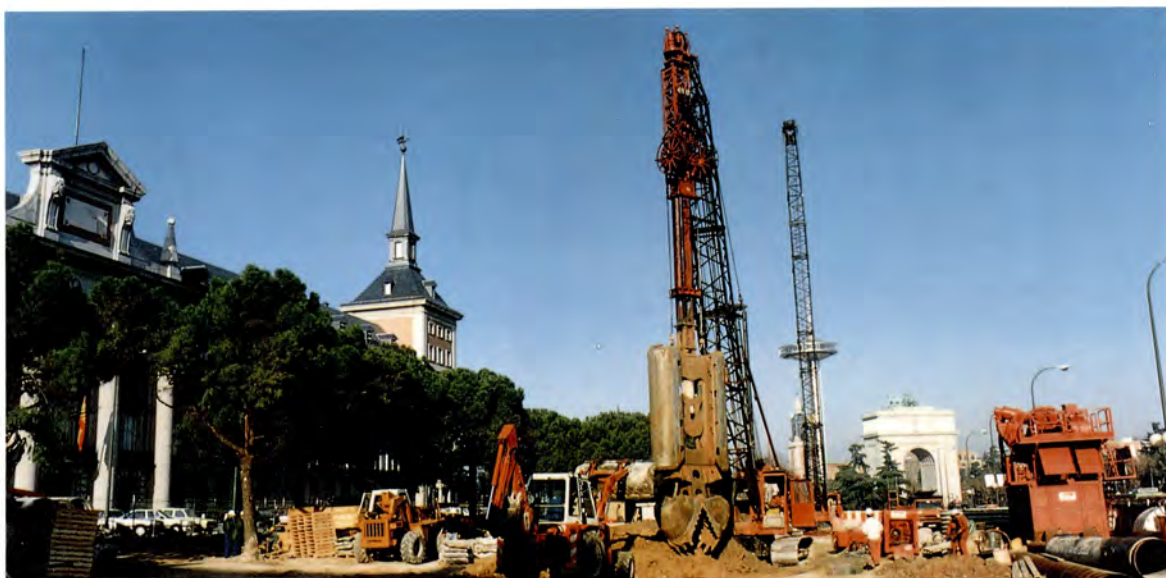
EXCAVACION DE PANTALLAS.
