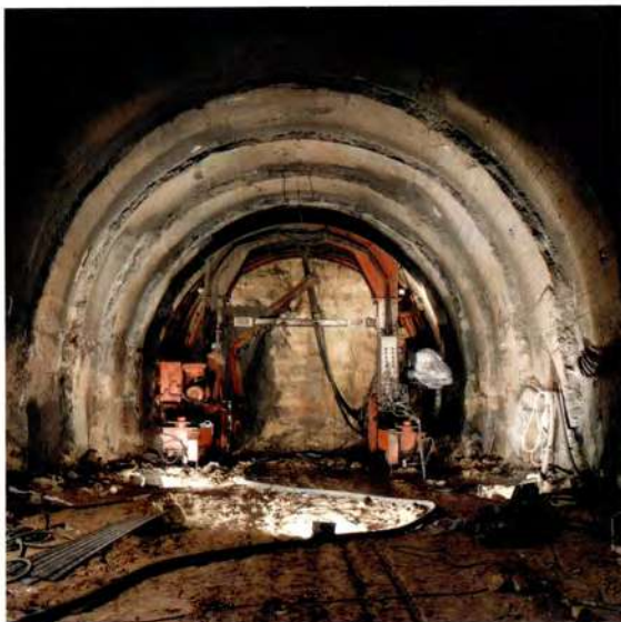
VISTA GENERAL DE PREBOVEDAS.
