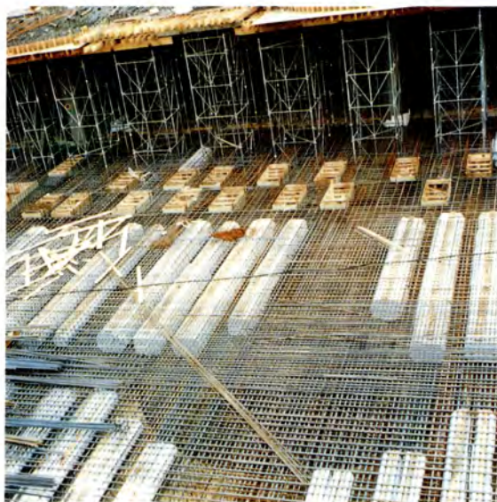
LOSA COTA 651 LADO INTERCAMBIADOR ANTES DEL HORMIGONADO.
