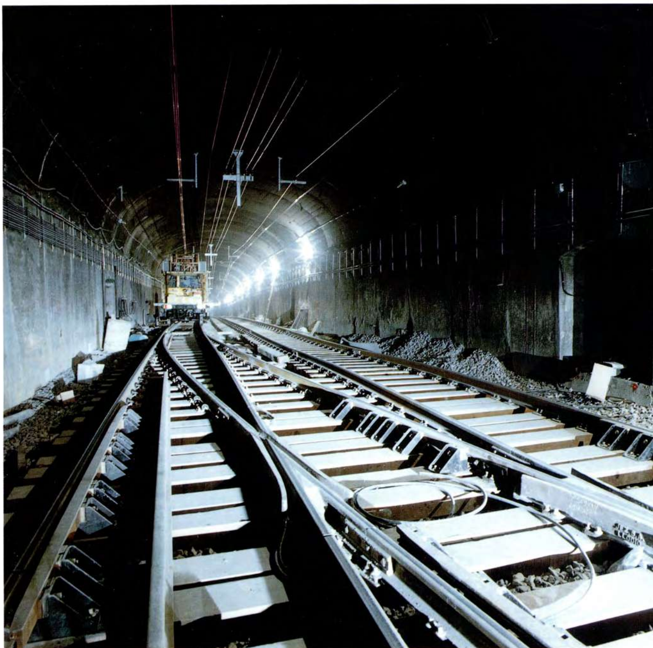
ASPECTO FINAL DE TUNEL DE LINEA.
