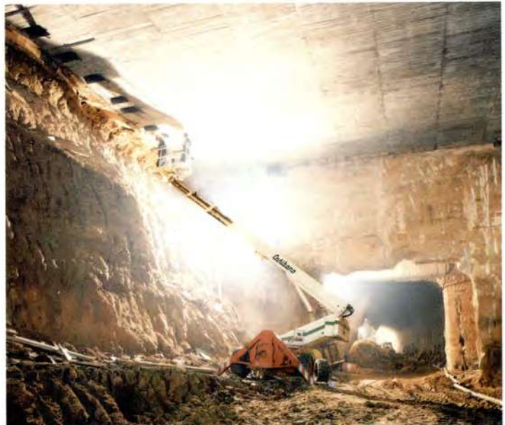
EXCAVACION DE LA CAVERNA.
