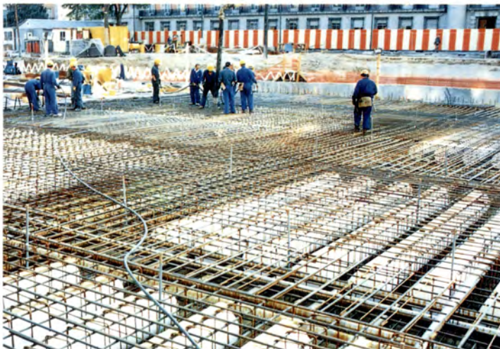
LOSA SUPERIOR DURANTE EL HORMIGONADO.
