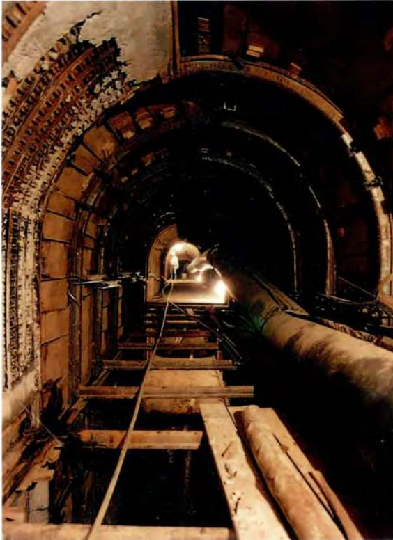
GALERIA DE AVANCE EN HASTIAL.
