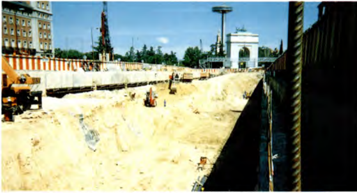
EXCAVACIÓN ENTRE PANTALLAS PROVISIONAL Y DEFINITIVA.
