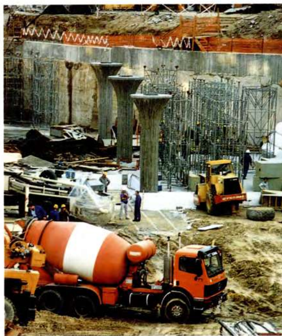
EXCAVACION DE LA ULTIMA MITAD DE LA ESTACION DE AUTOBUSES.
