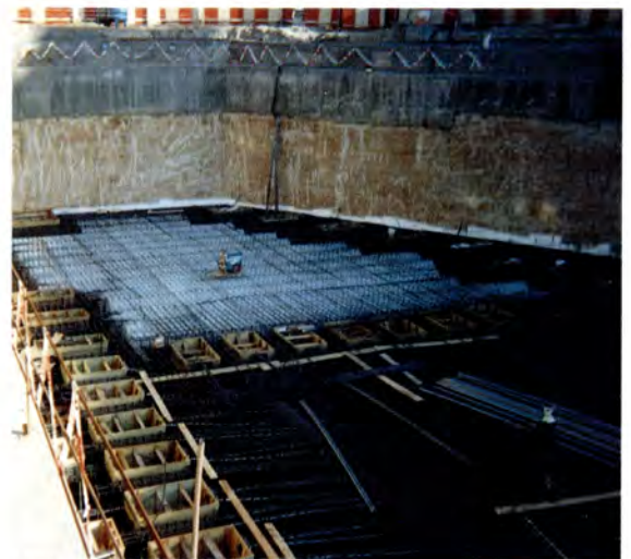
LOSA 651 LISTA PARA HORMIGONAR.
