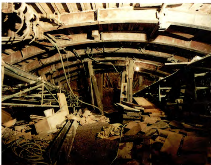
ENCOFRADO DE BOVEDA.
