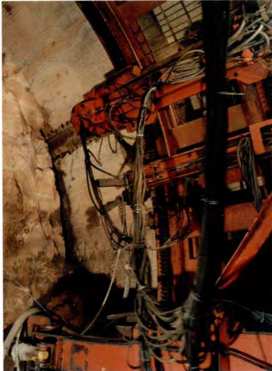
EJECUCION DE PREBOVEDA.
