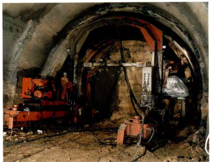
MAQUINA DE CORTE Y GUNITADO.
