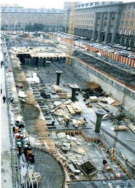
LOSA DE CALLE. ULTIMA FASE.
