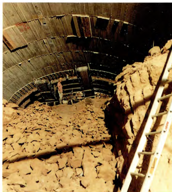
TRABAJOS DE EXCAVACION.
