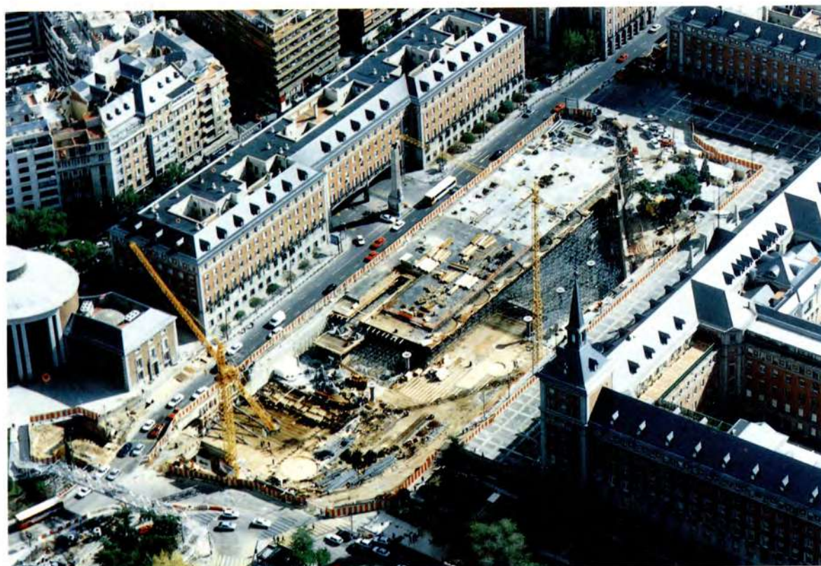
VISTA AEREA DE LA OBRA EN UNA FASE DE GRAN ACTIVIDAD.
