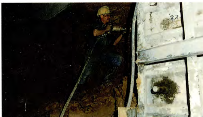
EXCAVACION DE HASTIALES.
