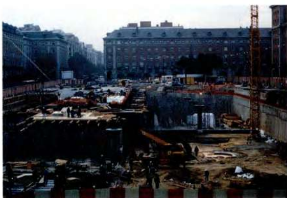
CIMBRA Y ENCOFRADO DE LOSA DE CALLE.
