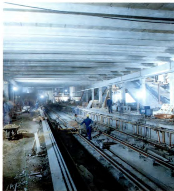
VISTA DE LA LOSA 646.20 DESDE ANDENES.
