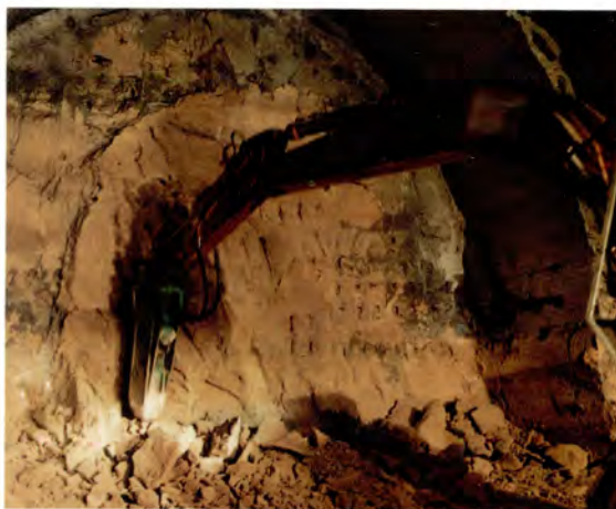
EXCAVACION DE SECCION COMPLETA.
