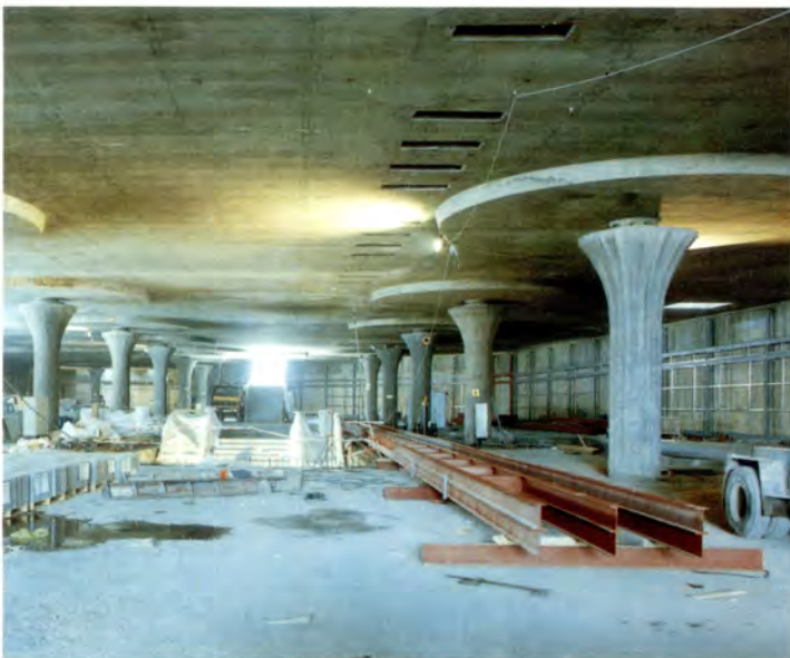
PLANTA DE AUTOBUSES Y PILARES.
