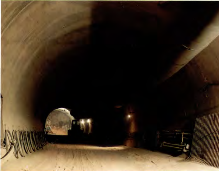
ASPECTO FINAL SECCION METODO PRECORTE.
