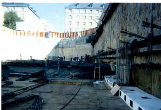
ENCOFRADO, FERRALLA Y ACERO ACTIVO DE LOSA 651.
