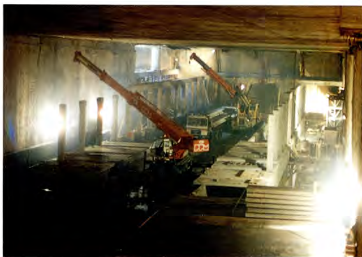
MONTAJE DE ELEMENTOS PREFABRICADOS.
