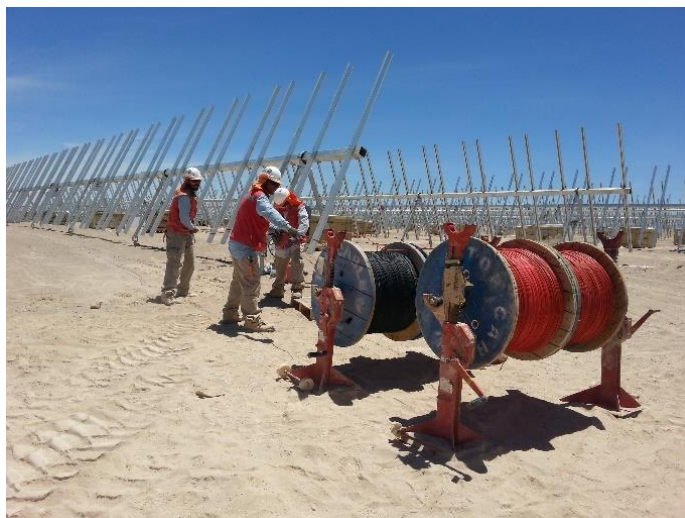
Imagen 7. Tendido de cables eléctricos.
