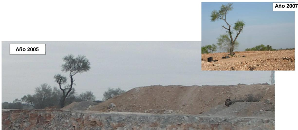
Figura 5.6. La escombrera situada en el extremo NO del hueco, constituida por las tierras de cobertera decapadas durante la apertura del hueco inicial, se ha empleado en cubrir los taludes finales remodelados, habiéndose eliminado totalmente su impacto sobre el medio. Abril 2007.
