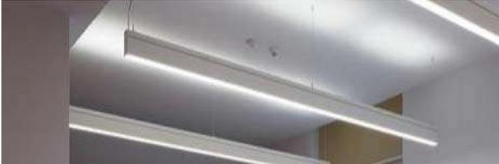
Sobre los paneles decorativos de madera hilo de led tipo Undescore de Iguzzini o equivalente, con control de potencia y difusor.
