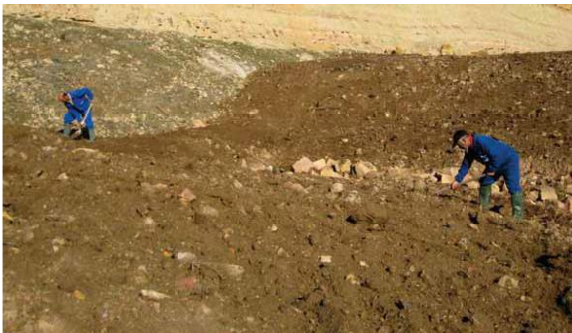
Fig. 59. Perfilado a mano de un extendido de tierra vegetal sobre superficie minera rehabilitada.
