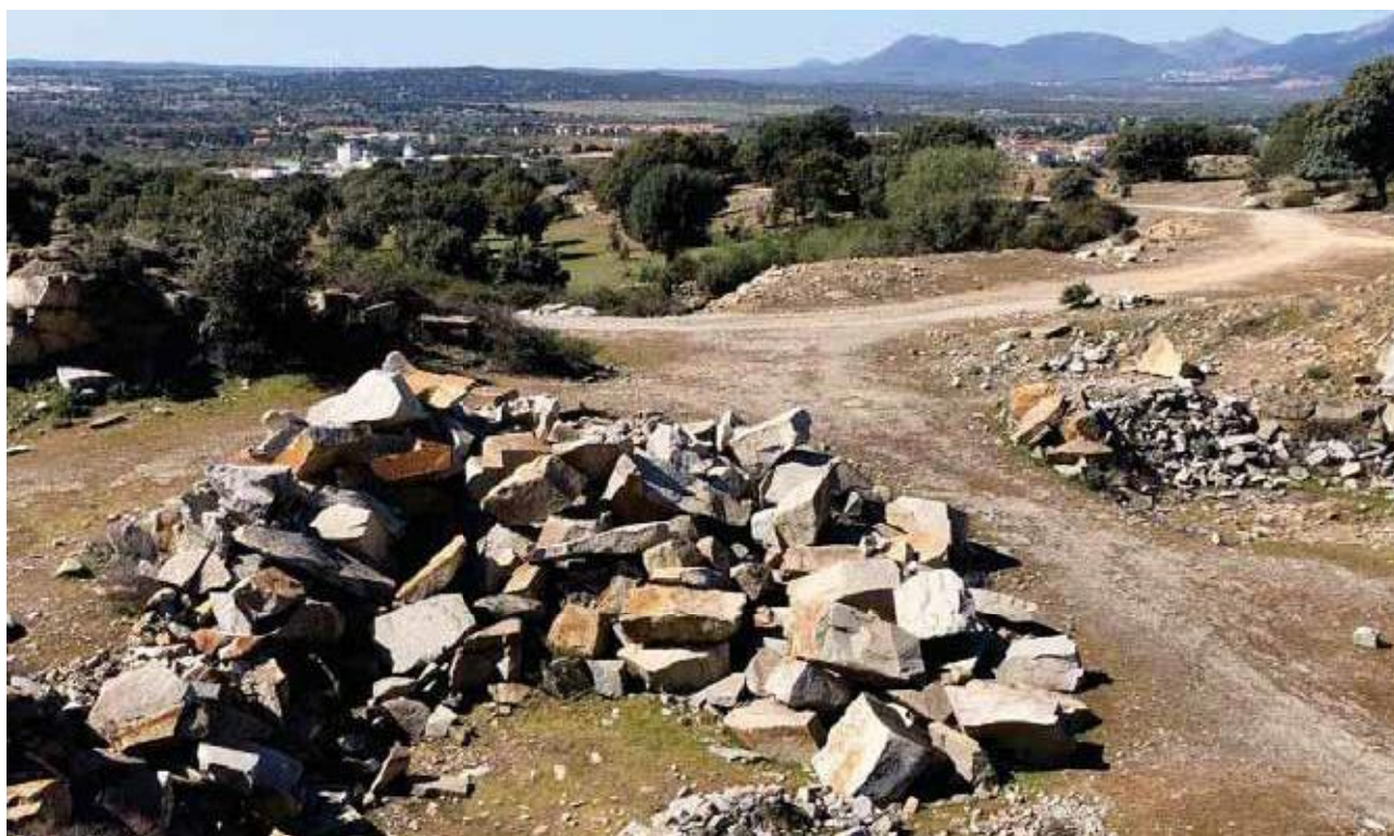
Fig. 28. Acopio de grandes bloques de roca granítica, en el interior del hueco 26.71. Con el fin de minimizar el movimiento de tierras, y de maximizar la integración ecológica y geomorfológica, el diseño geomorfológico ha hecho coincidir estos materiales con una pequeña divisoria entre los dos pequeños cauces que drenarán el hueco 26.71.
