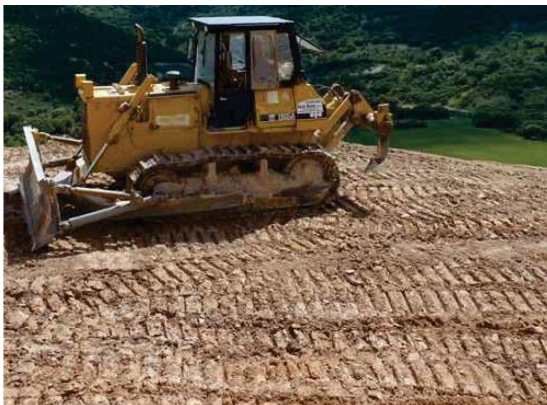
Fig. 58. Imagen superior, aspecto del acabado del extendido de tierra vegetal en el proceso LIFE RIBERMINE (tonos oscuros). Véase el aspecto rugoso y pedregoso. Imagen inferior, ejemplo de acabado superficial de alta rugosidad realizado con las huellas de las propias cadenas del buldócer al transitar sobre un suelo que se encontraba en condiciones óptimas de humedad (próximo a su 'estado de tempero'). Restauración de la cantera de Somolinos. Ambos efectos son deseables en los acabados superficiales del extendido de la tierra vegetal de las canteras de Alpedrete.
