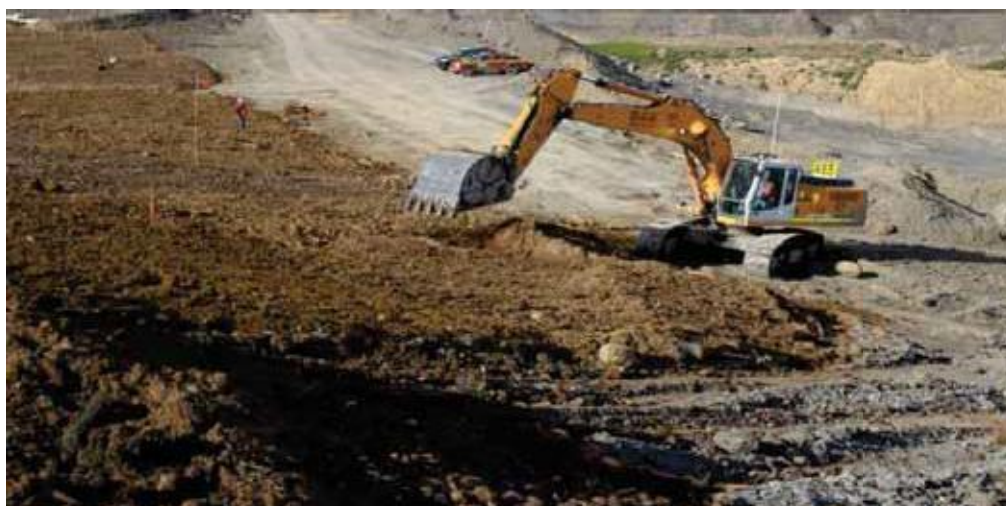
Fig. 55. Extendido de tierra vegetal con cazo de retroexcavadora, dejando superficies rugosas.
