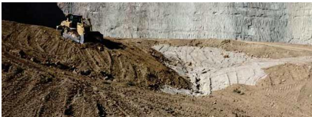
Fig. 56. Extendido de tierra vegetal sobre remodelados de tipo geomorfológico en el proyecto LIFE RIBERMINE. Las zonas de coloración clara, en el centro-derecha de la imagen, son estériles arenosos, altamente erosionables, de modo que es crítico que éstos queden perfectamente recubiertos por la tierra vegetal. Del mismo modo al ejemplo de la imagen, se deberá garantizar un recubrimiento adecuado de todos los estériles de las escombreras de los MUP 26 y 27 de las canteras de Alpedrete, una vez remodeladas geomorfológicamente.
