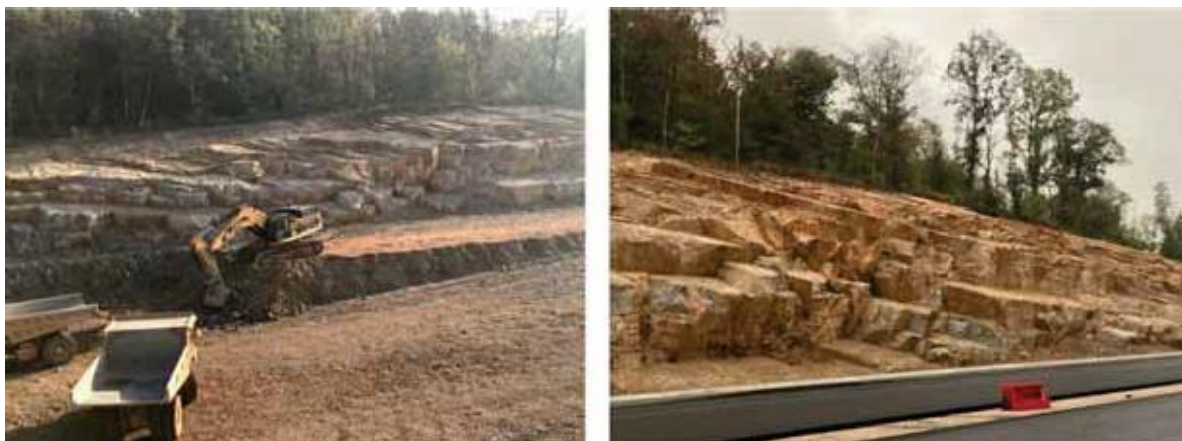
Fig. 61. Ejemplos de remodelado geomorfológico de taludes rocosos. Izquierda, final de la fase operativa. Derecha, acabado final. Carretera RN 19, Departamento de Alto Saona (Haute-Saône) Francia. La estructura del nuevo talud rocoso se articula a partir de sus discontinuidades. Fotos: Paul Royal (Francia). Nótese que el aspecto de la imagen de la derecha, en el que se identifican bien los distintos planos de discontinuidad, es el que deberá buscarse en los frentes de las canteras de Alpedrete. Pero exclusivamente con el uso del cazo de la retroexcavadora.
