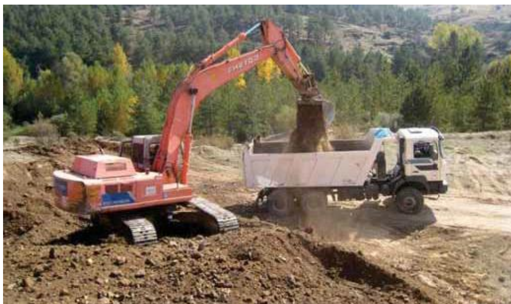
Fig. 54. Proceso de carga de tierra vegetal en camión de obra, para su extendido sobre zonas ya remodeladas geomorfológicamente.
