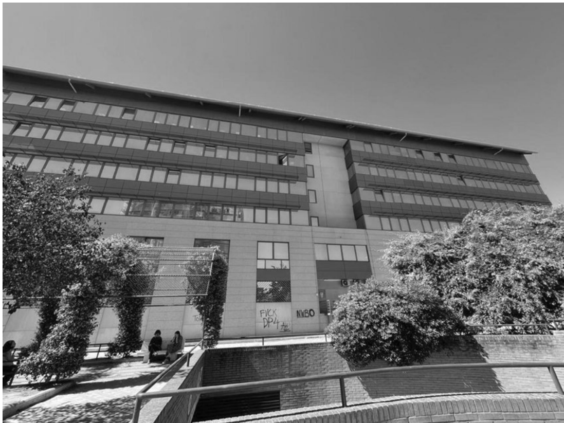
Imagen 1: Fotografías estado actual. Fuente: Propia
