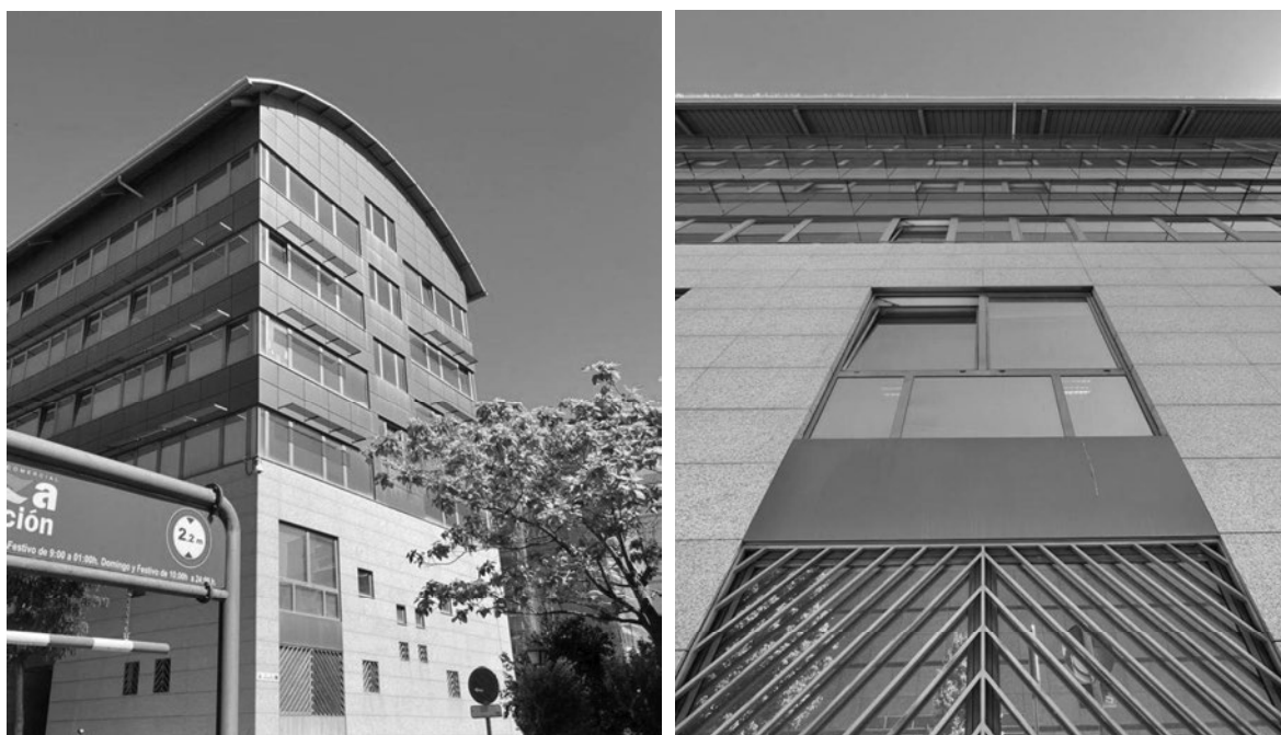
Imagen 6. Dispositivos de sombra en el edificio de Juzgados.
