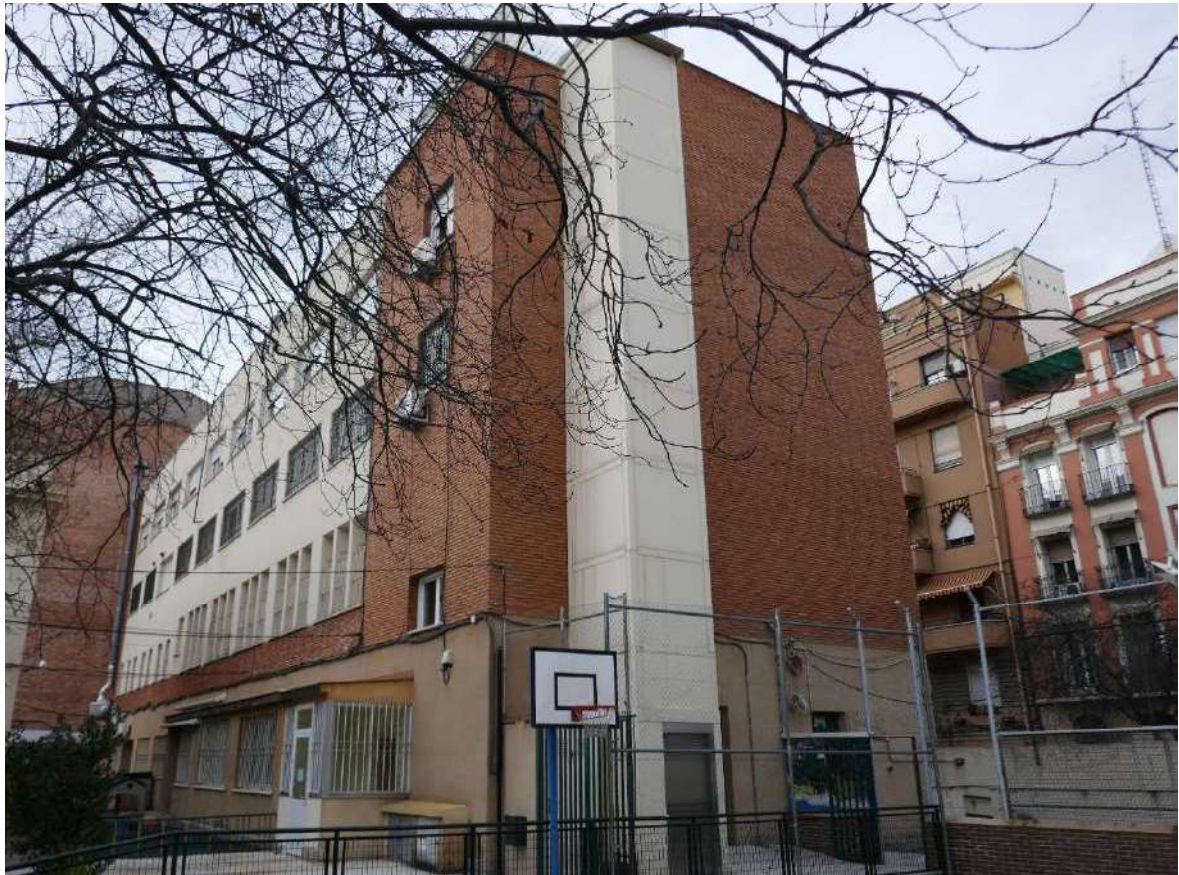
FACHADA A PATIO INTERIOR Y FACHADA LATERAL
