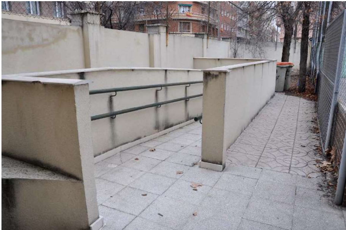
ZONA INTERIOR LATERAL
