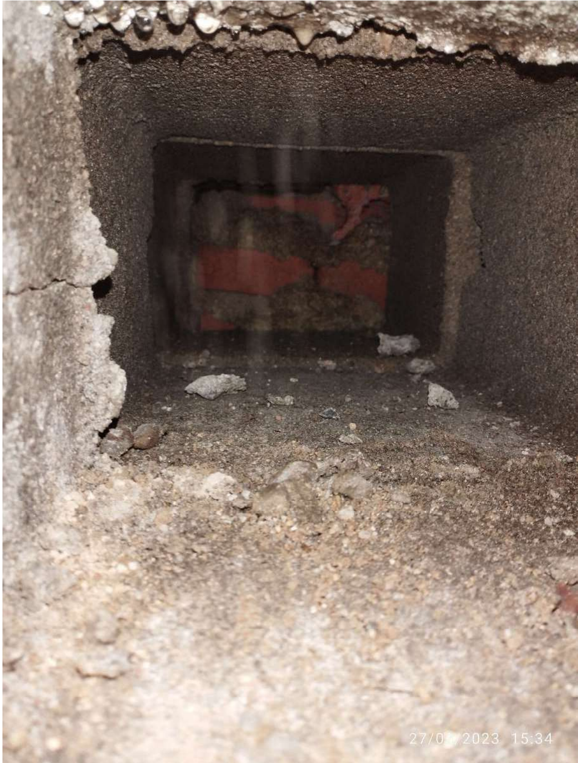
CAMARA INTERMEDIA FACHADA / MURO CIMENTACION INTERIOR
