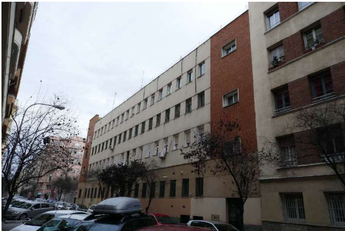
FACHADA C/ DONOSO CORTES
