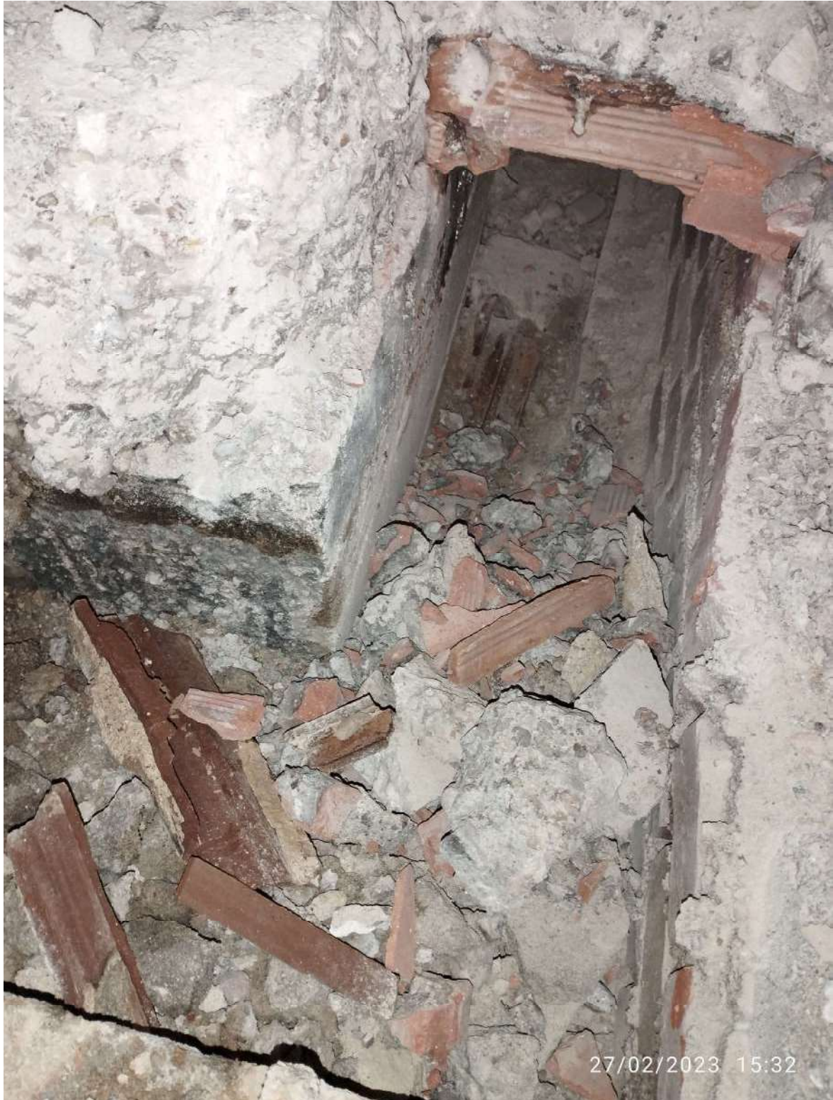
CATA BAJO DESCANSILLO ESCALERA
