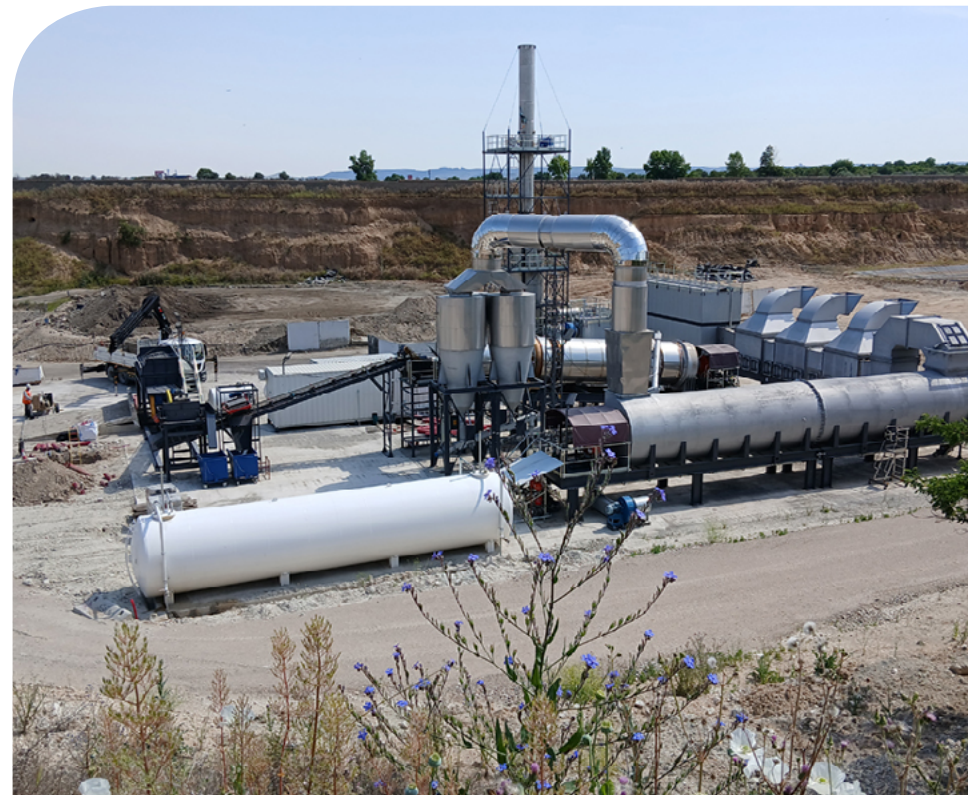
Planta de desorción térmica instalada en la laguna de los aceites.
