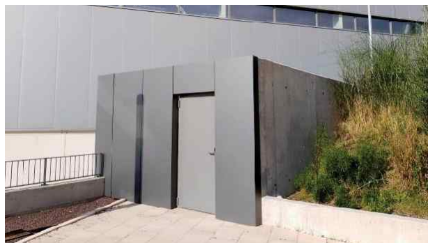
Imagen 11. Caseta de escalera de emergencia
